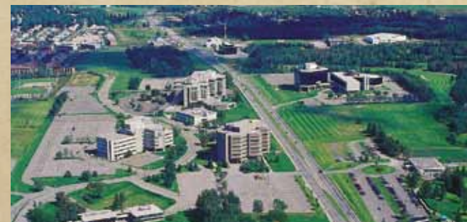
Cité Desjardins de la coopération in Lévis, the head office of the Fédération des caisses Desjardins du Québec. The Desjardins Group is the largest financial group in the Province of Québec (Fédération des caisses Desjardins)
