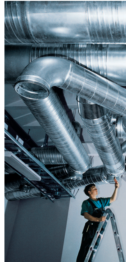
Abb. 3: Kanäle aus Feinblech mit Zinküberzug für die Lüftungs-/Klimatechnik
