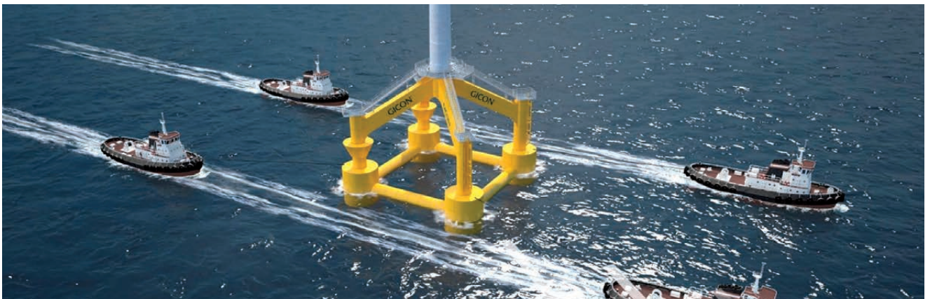
Abbildung 7: Schleppvorgang der Plattform inkl. WEA zum Offshore-Errichtungsort © GICON Großmann Ingenieur Consult GmbH
