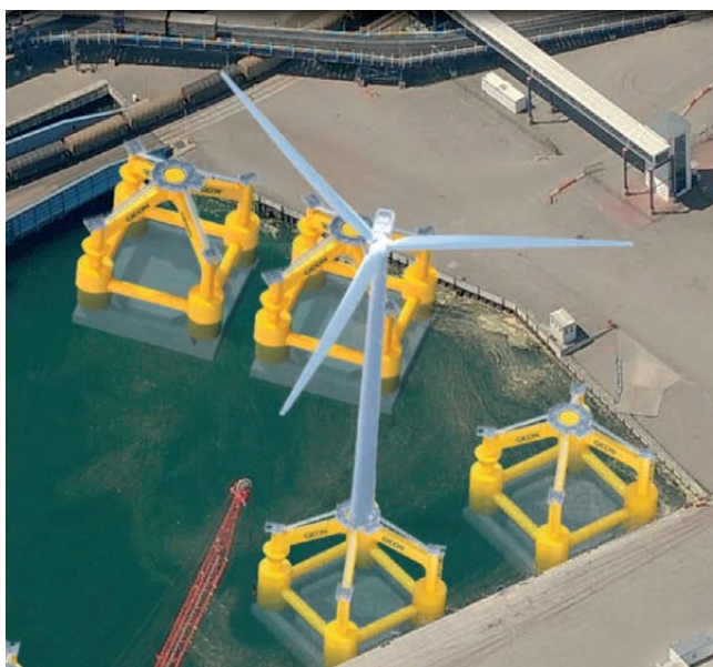
Abbildung 2: Zusammenbau des Gesamtsystems an der Kai-Kante © GICON Großmann Ingenieur Consult GmbH
