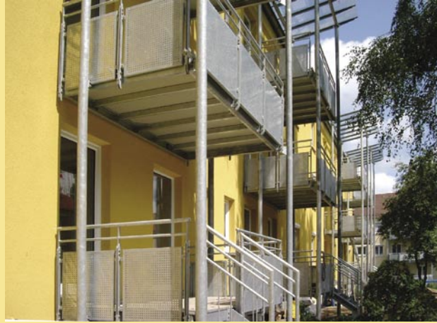
Abbildung 14: KfW-40 Haus: Ingolstädter Straße in Nürnberg (WBG Nürnberg)
