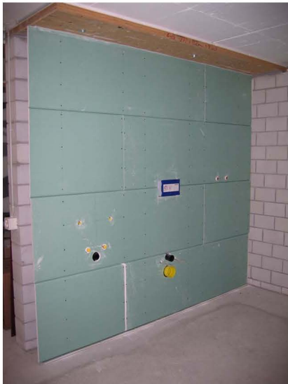
Bild 89: Raumhohe Geberit Duofix Vorwandinstallation
