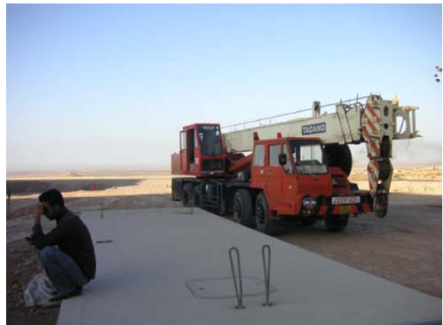
Montage der Fahrzeugwaage mit einem 25-Tonnen-Kran
