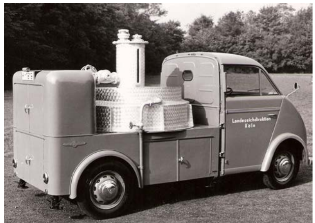
Historische Eichgerätschaft für Tankstellen
