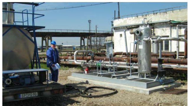
Inbetriebnahme einer kompletten Messanlage gemäß 2004/22/EG zur Messung von Ethanol, bestehend aus Filter, Gasabscheider, Ovalradzähler, Dichteaufnehmer und Durchflussrechner.
