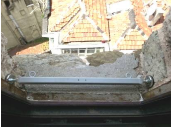
Şekil 3: LED Armatürün Montaj Donanımı
