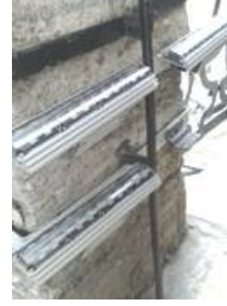
Şekil 5: LED Armatürün Montajı
