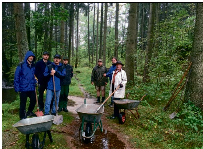
Mitglieder des FGV Brand und Ebnath behoben die Schäden am Main-Donau- und Max-Reger-Weg.
