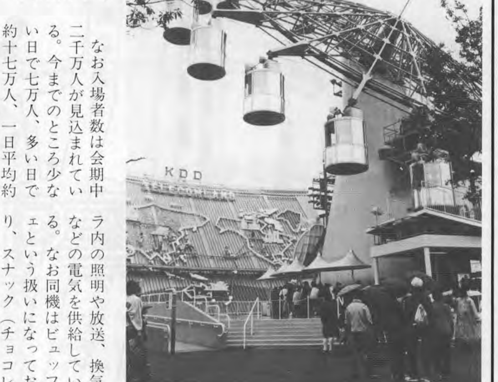
形レールを同機下部ではさんだタイヤを回すことにより、全体が回転する。最高部三十尺、回転部直径二十八尺、六人乗りゴンドラ二十個で定員百二十八人、一周八分間。ゴンドラは常に一定方向を向くようにしており、エアコン装備。眼下に大きな世界地図が広がり、ゴンドラ内のボタン操作で各国のランプが点灯し、管制塔との交信音やロケットの発音音がゴンドラ内に流れる。
