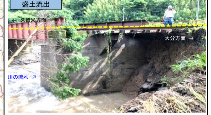
⑤久大本線 南由布・湯平間第六由布川橋りょう
