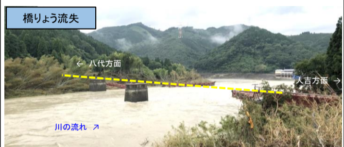
⑥肥薩線 那良口・渡間第二球磨川橋りょう
