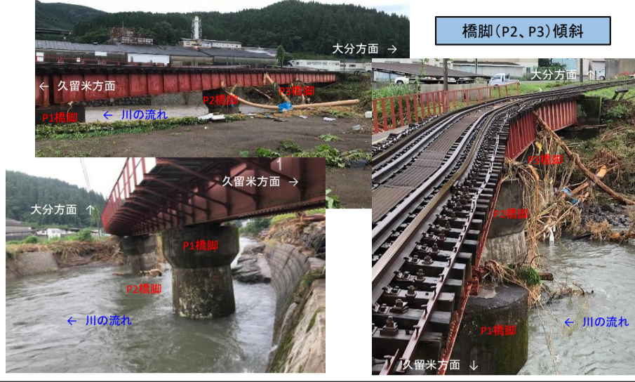
②久大本線 引治・豊後中村間第一野上川橋りょう
