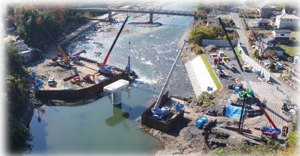
現場施工状況
