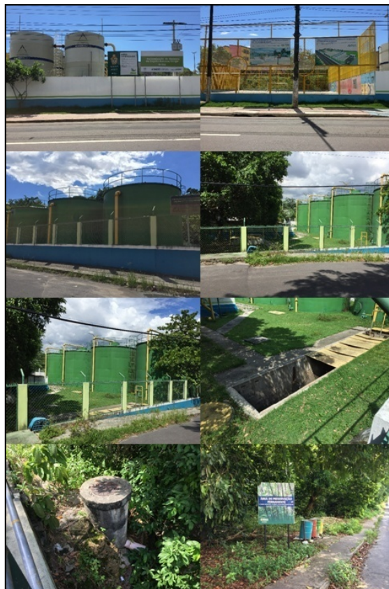
Figura 7.4: Relatório fotográfico - abastecimento de água de Manaus
