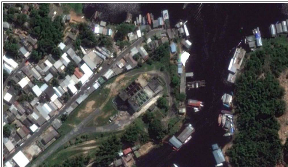
Figura 7.7: Estação de tratamento de água de Mauzinho
