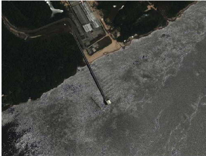
Figura 7.8: Vista da Captação de Água Bruta (CAB) da Ponta das Lajes
