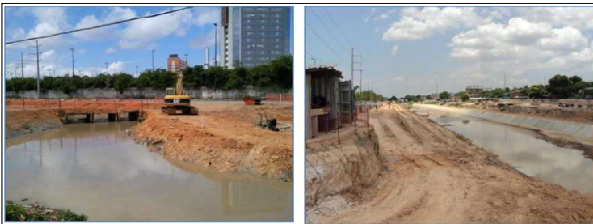
Figura 7.14: Obras de ampliação do igarapé do Quarenta.
