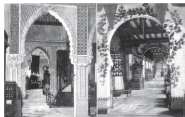
Fig. 125. “Ingreso á las naves del piso principal y á la bodega del piso bajo, en el Pabellón de España [sic] (De fotografía directa)”, en La Ilustración española y americana , año XXXIII (1889), nº XXXVI, 30 de septiembre, p. 181; y fig. 126 [abajo], “El Palacio de productos alimenticios, sobre el ‘Quai d’Orsay’ (De fotografía directa)”, en Ídem , año XXXIII (1889), nº XXXI, 22 de agosto, p. 97.
