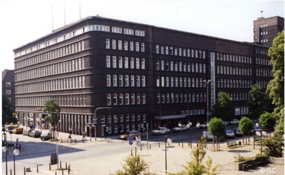
Das Hans-Sachs-Haus im Jahr 2002, kurz vor dem Beginn der geplanten Sanierung
