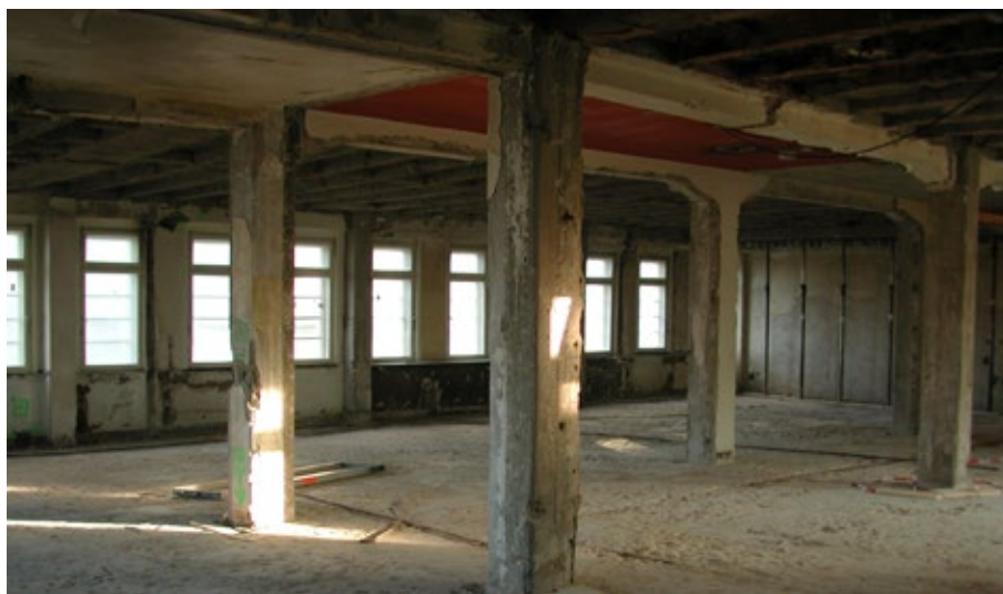
Vollständig entkernte Innenräume des Hauses im Rahmen des Risiko-Screenings
