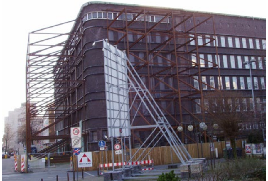
So präsentierte sich die Baustelle nun lange Zeit bis zum Neustart der Sanierung
