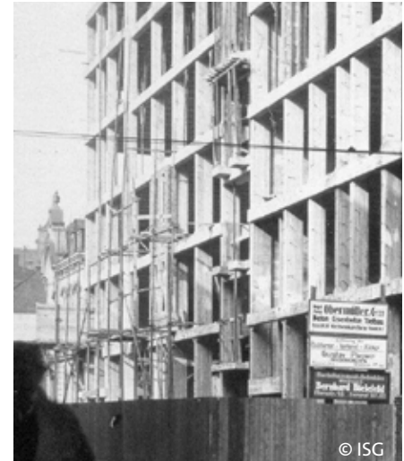
Baustelle 1925 mit Bauschildern
