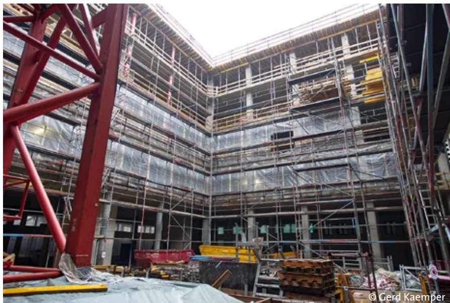
Die Großbaustelle Hans-Sachs-Haus, hier der noch offene Innenbereich im Jahr 2011
