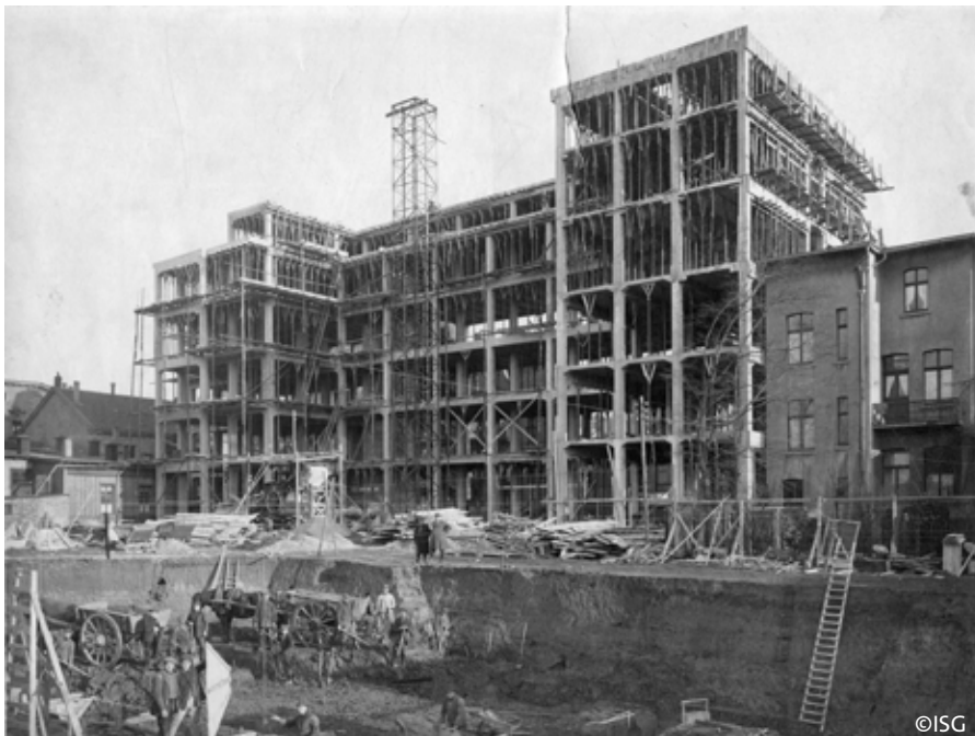
Die Baustelle „Hans-Sachs-Haus“ im Jahr 1925
