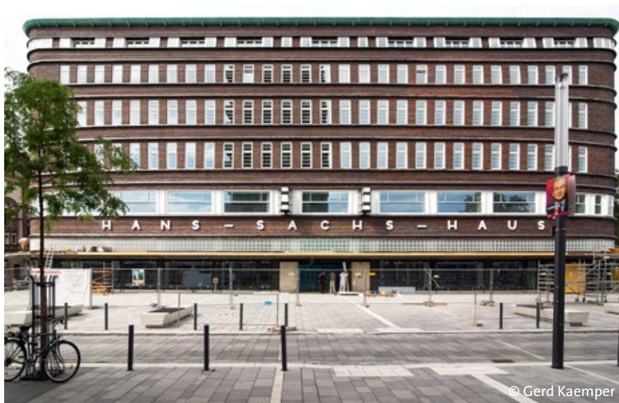
14. August 2013 - Gut zwei Wochen vor der Eröffnung - noch immer mit Bauzaun - trägt das Haus wieder seinen Namen in Buchstaben an der Fassade
