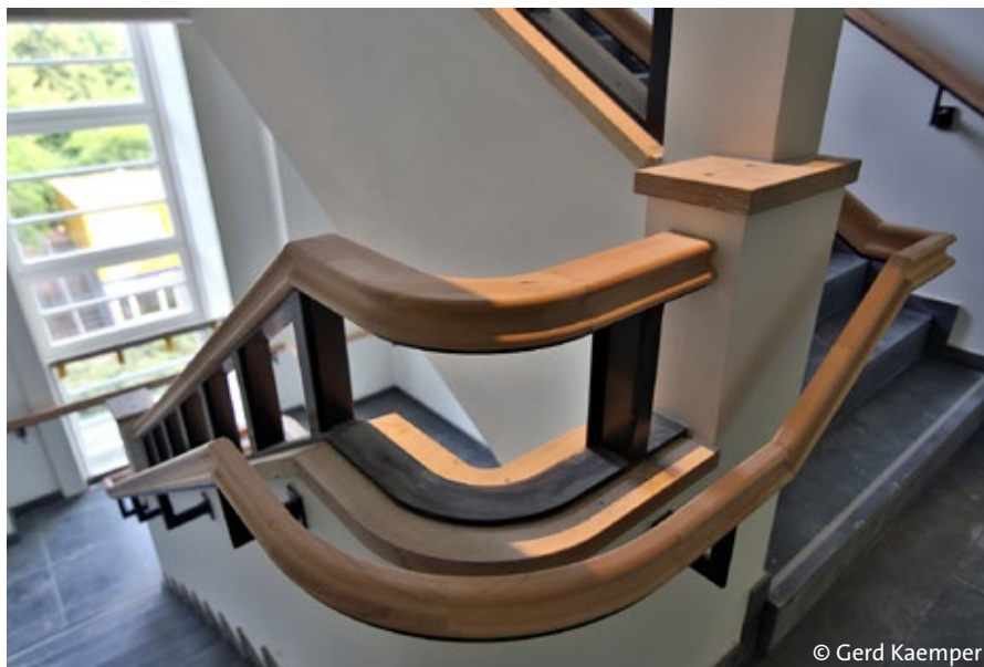
30. Juli 2013 - Blick in ein neues, altes Treppenhaus - die Handläufe wurden originalgetreu erneuert
