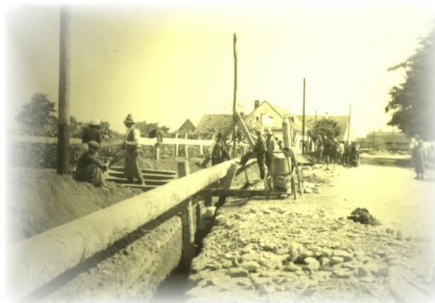
Fig. 3. Asamblarea în fir continuu a conductei înaintea poziționării în șanț [7].
