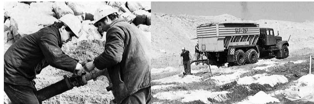
Vorbereitung der Sprengung in der Quarzitbank, 1987 Sprengstoffladefahrzeug auf fertiggestellter Sprengfläche, 1987 Sprengung einer Quarzitbank im Tagebau Profen, 1987
