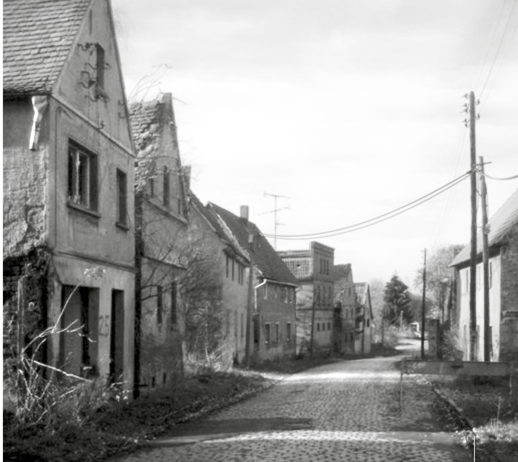
Straßenzug in Großgrimma vor dem Abriss, 2006
