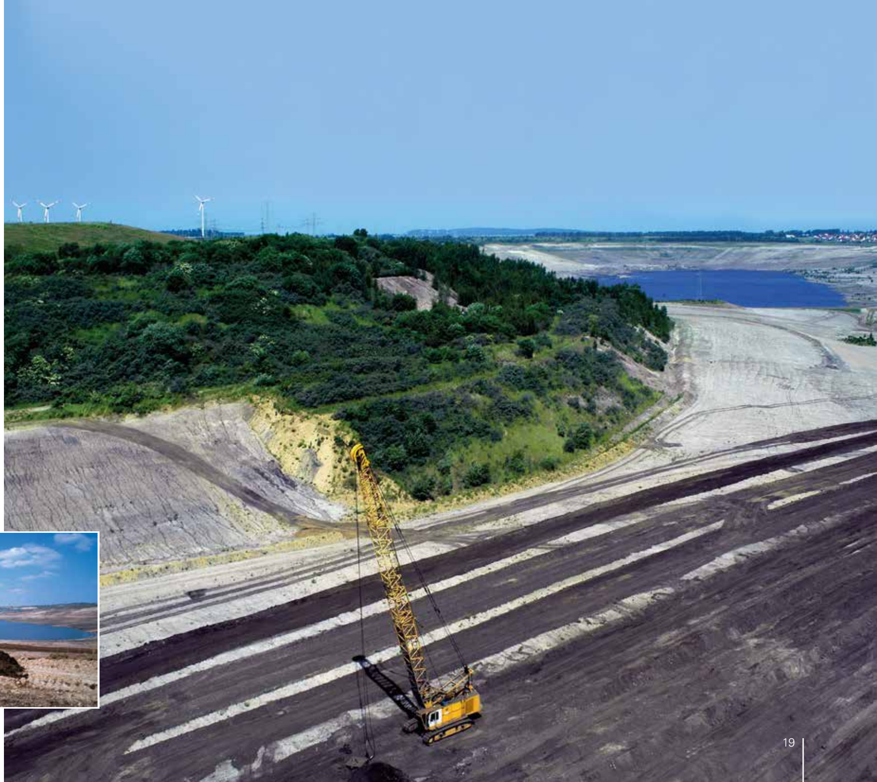
Verdichtung der Innenkippe im stillgelegten Tagebau Wulfersdorf mittels Fallplatte, 2006
