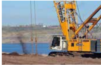
Fallplattenverdichtung im Sanierungstagebau Wulfersdorf, 2013
