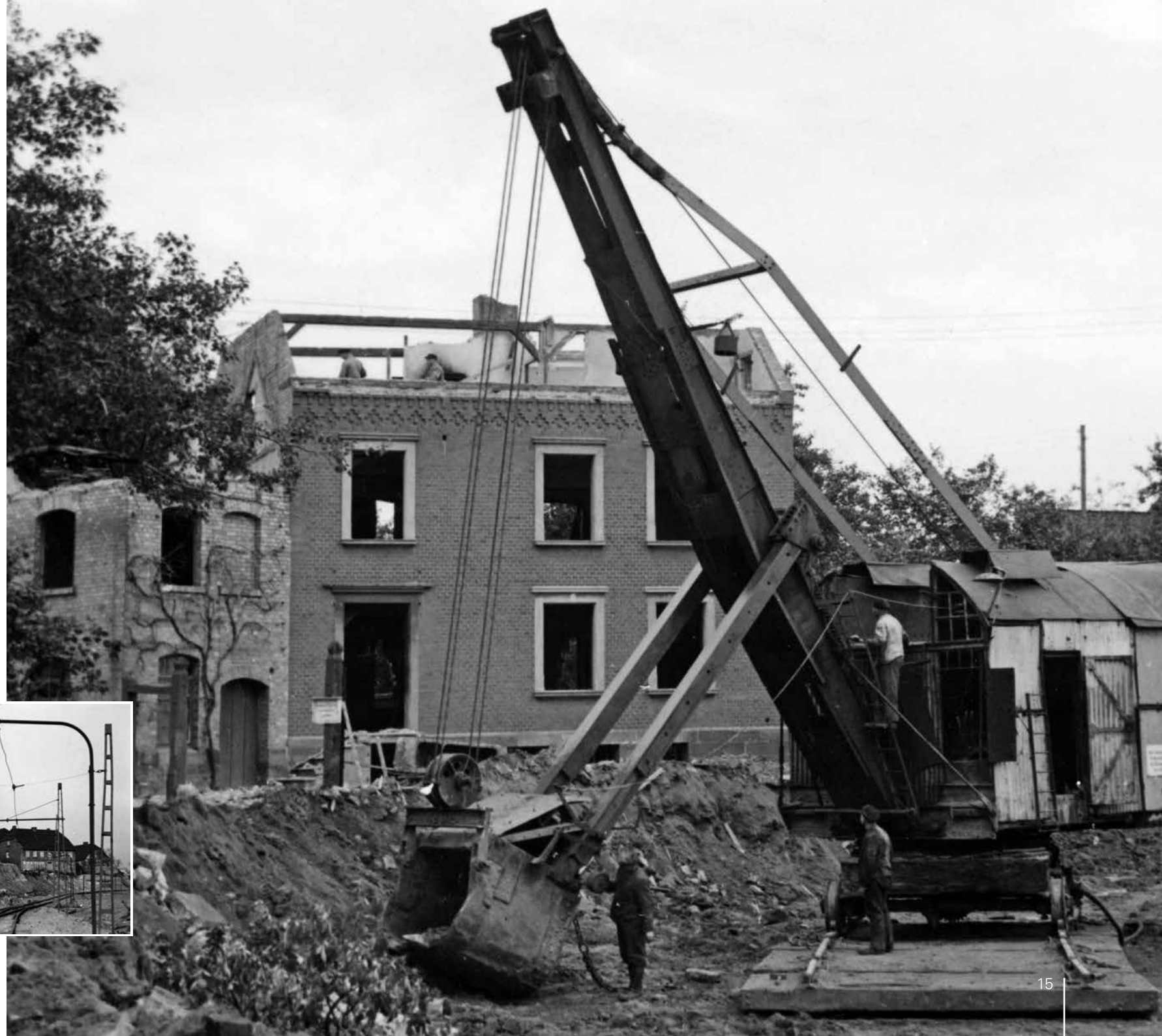
Abbruch eines Wohnhauses in Büddenstedt, 1940
