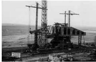
Montage eines Baggers im Tagebau Wulfersdorf, 1936
