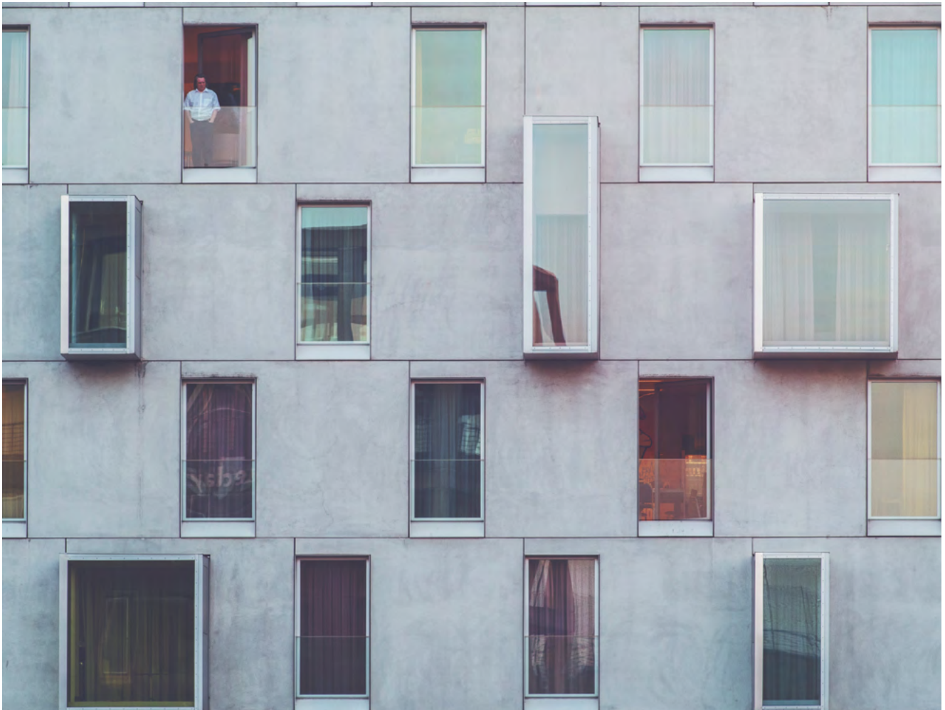
Die Fensterfront eines Betongebäudes. Quelle: Daniel von Appen, Unsplash.
