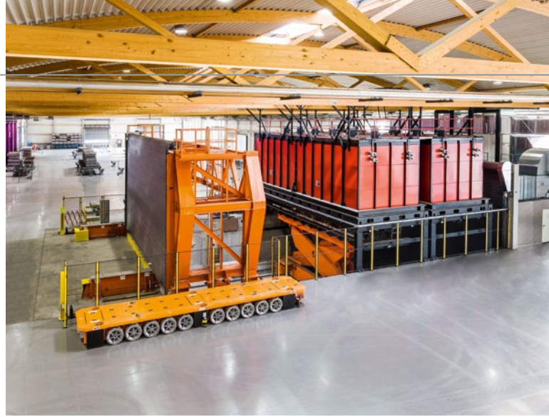
Warmauslagerungsöfen in der Plattenfertigung
