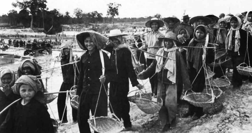
Arbeiter*innen beim Errichten eines Dammes (Foto: DC-Cam).
