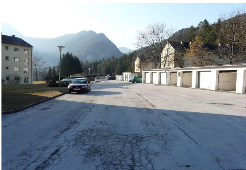
Foto 19: Gemeindebauten beim Freibad
