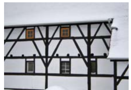
97 | Abgewandte Traufe mit wiederhergestelltem Langständergefüge. Die zugewandten Seiten sind hingegen in Stockwerkbauweise errichtet.
