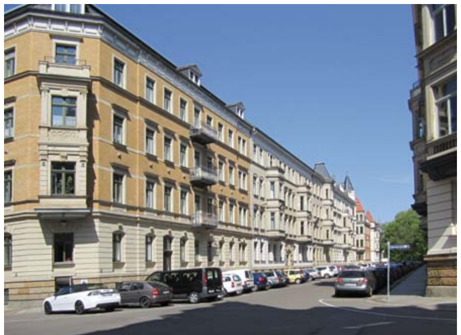
49 | Waldstraßenviertel nach der Sanierung
