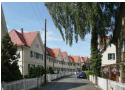
84 | Am Dorffrieden, Blick nach Norden, nach der Sanierung, 2011
