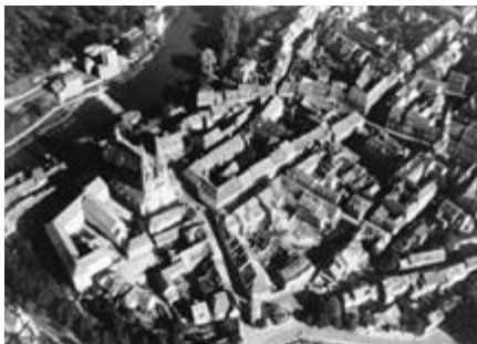
2 | Östlicher Altstadtbereich von Nordwest mit Peterskirche und Untermarkt, vor 1988
