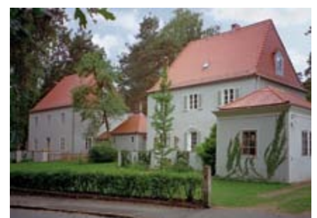
81 | 82 | Heideweg 24, Blick von Nordosten, vor der Sanierung, 1996 und nach der Sanierung, 2000
