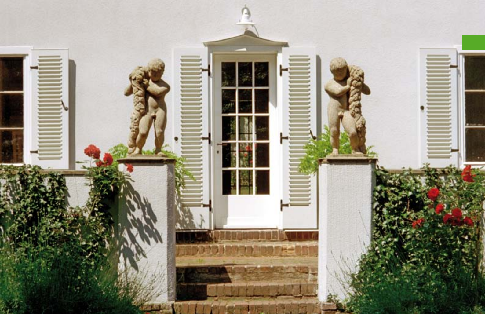
83 | Heideweg 24, Blick von Osten (Detail Zugang), nach Sanierung, 2000
