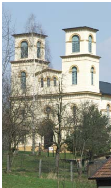
135 | Zustand nach der Sanierung, 2006
