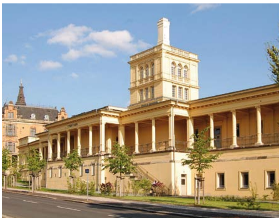
66 | Ansicht nach der Sanierung, 2011
