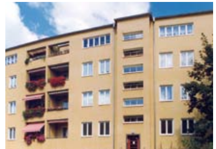
73 | Äußerer Ring nach der Sanierung
