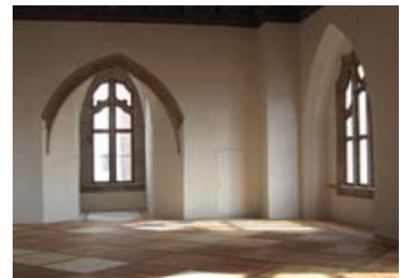
106 | Saal mit restauriertem Fußboden im 3. Obergeschoss
