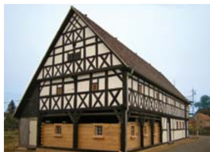
96 | Ansicht des Wohnstallhauses während des Wiederaufbaus im Museum Schwarzbach
