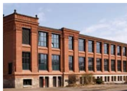
119 | 120 | Wasserbau vor und nach der Sanierung
