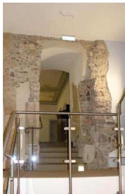
36 | 37 | Eingang ins Obergeschoss, Vorzustand während der Bauarbeiten und nach der Sanierung
