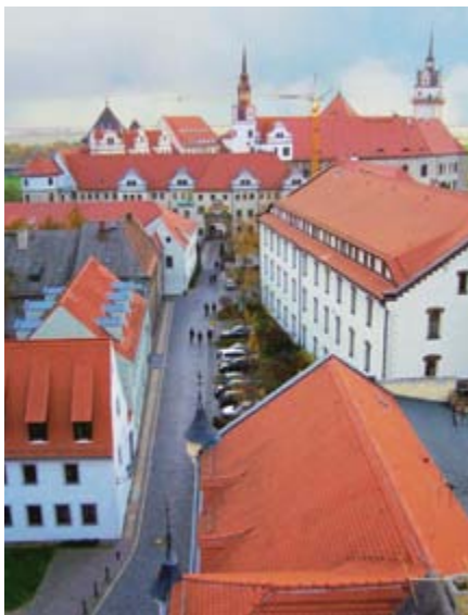
18 | Blick von der Marienkirche zum Schloss, rechts davor das sanierte Zeughaus, heute Heimerer-Schule
