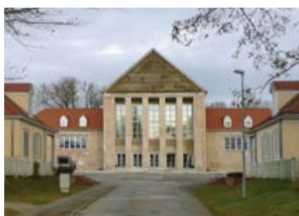
77 | 78 | Festspielhaus Hellerau von Süden, vor der Sanierung, 1996 und 2009 (Gesamtsanierung noch nicht abgeschlossen)
