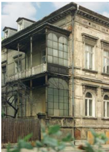
50 | Balkon in der Christianstraße 6 vor der Sanierung
