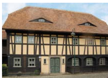
86 | 87 | Großschönau, Theodor-Haebler-Straße 25, Zustand um 2000 und nach der Sanierung 2011
