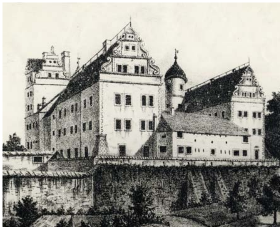
110 | Ansicht von Osten, Zustand 1829 vor dem Abbruch der östlichen Volutengiebel
