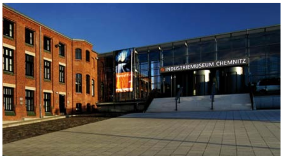
118 | Außenansicht nach der Sanierung
