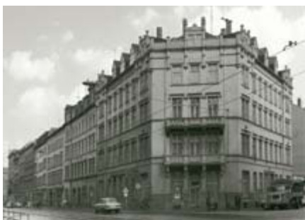
48 | Waldstraßenviertel vor der Sanierung
