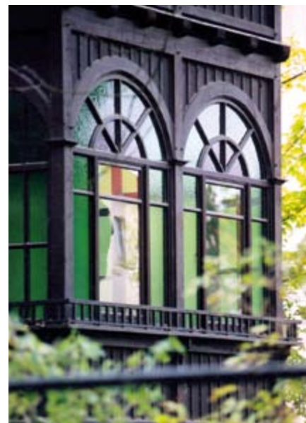
51 | Balkon in der Christianstraße 6 nach der Sanierung
