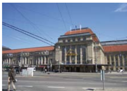
69 | Eingangsgebäude nach der Sanierung, 1997
