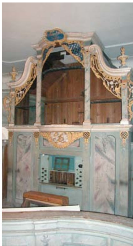
168 | Orgel während der Restaurierung; die Prospektpfeifen, das gesamte Innen-Pfeifenwerk, die Klaviatur und die Spielschranktüren sind ausgebaut.
