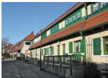
85 | Am Grünen Zipfel, Blick nach Norden, nach der Sanierung, 2011
