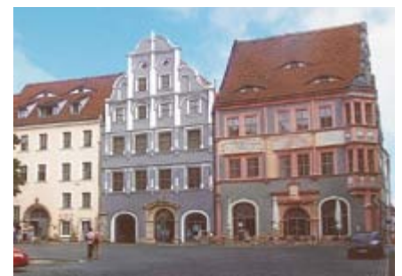
8 | 9 | Blick auf die Nordseite des Untermarktes vor und nach der Sanierung
