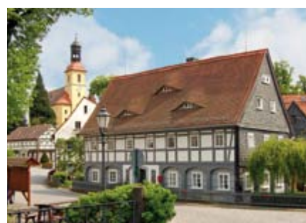
92 | Großschönau, Ortsbild im Umfeld der Dorfkirche, 2011
