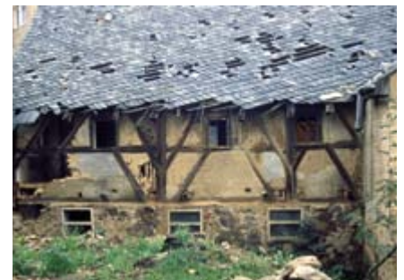
95 | Abgewandte Traufe des Wohnstallhauses in Poppitz. Das Erdgeschoss wurde in Bruchstein ersetzt.
