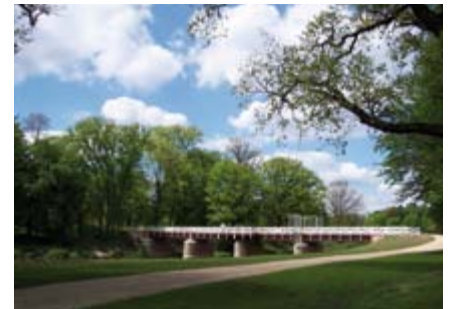
143 | Neiße-Doppelbrücke nach dem Wiederaufbau, 2005
