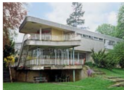
40 | Gartenseite vor der Sanierung, 1998
