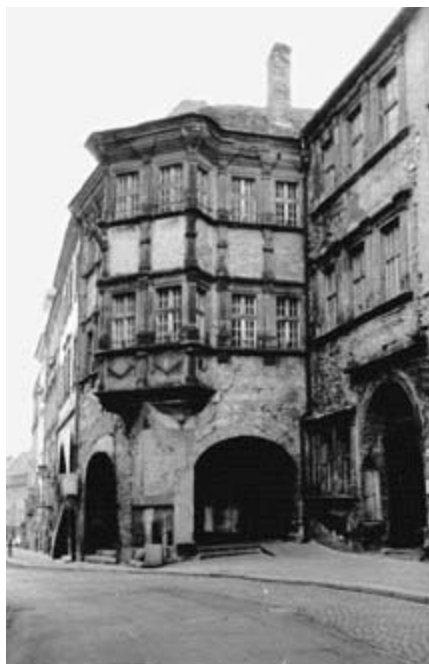
3 | Brüdergasse 8, vor der Sanierung, um 1989
