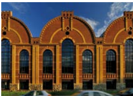
115 | Außenansicht nach der Sanierung
