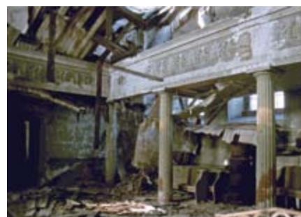
133 | Kircheninnenraum vor der Sanierung, 1987
