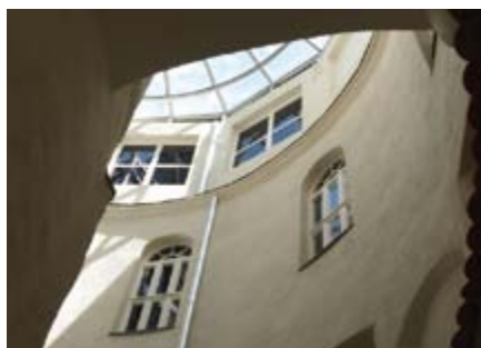
63 | Ehemaliger Innenhof mit Glasdach, Aufzug und Treppenzugang zum Untergeschoss
