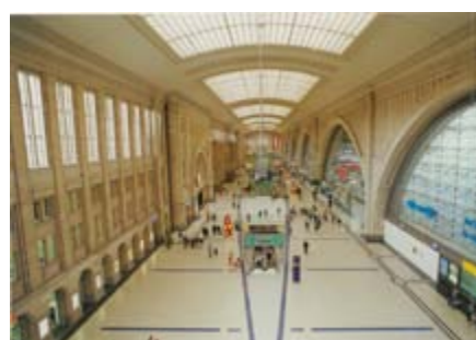
70 | 71 | Querbahnsteig während des Umbaus 1995 und nach Fertigstellung, 1997
