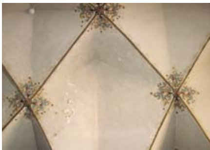
104 | Zellengewölbe mit historistischer Dekorationsmalerei vor der Restaurierung
