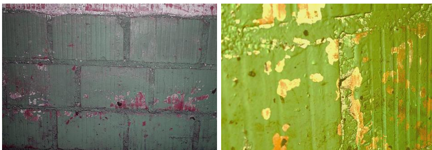
Abbildung 3: Betrieb-01: PCB-haltige Wandfarben
