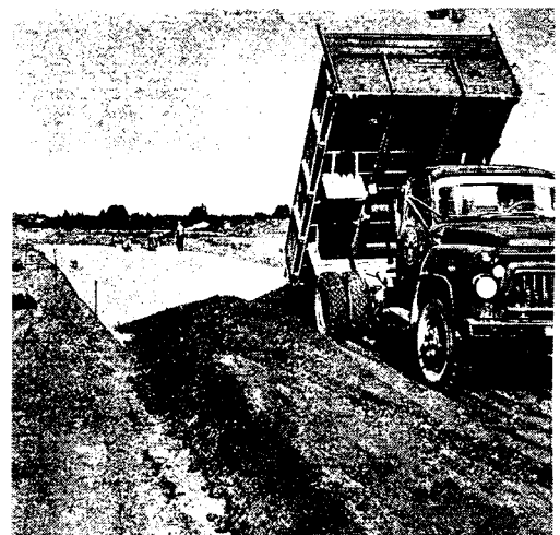
Конструкция насыпи из переувлажненных грунтов
