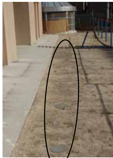
非常時にトイレとして使用できるマンホールトイレ
