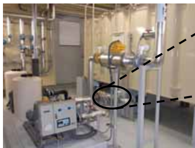
受水槽の水を取り出せる水栓を設置
