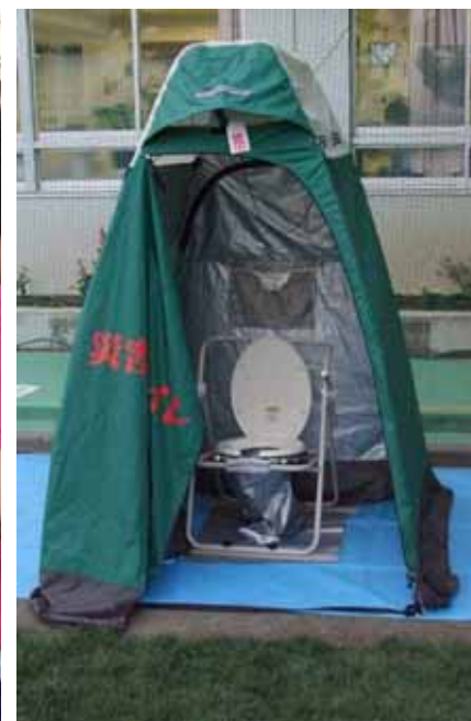
マンホールトイレ設置の様子
