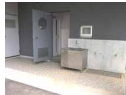
外部から利用できるトイレ
