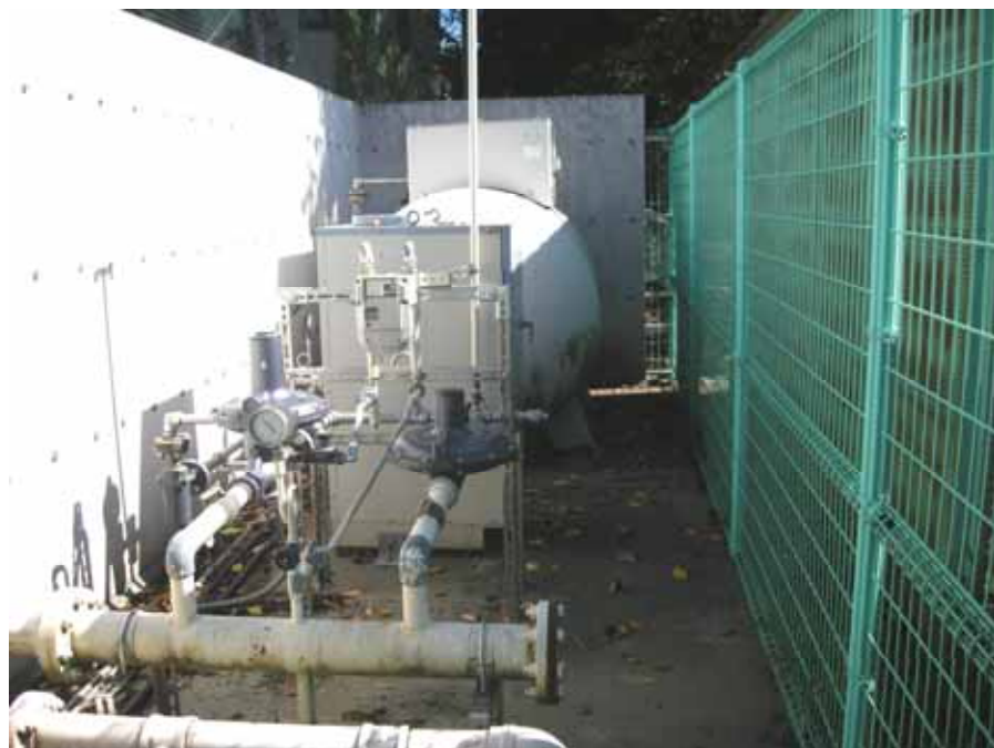
災害に強いバルク供給方式を採用したLPガス供給設備
