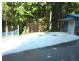
耐震性貯水槽
