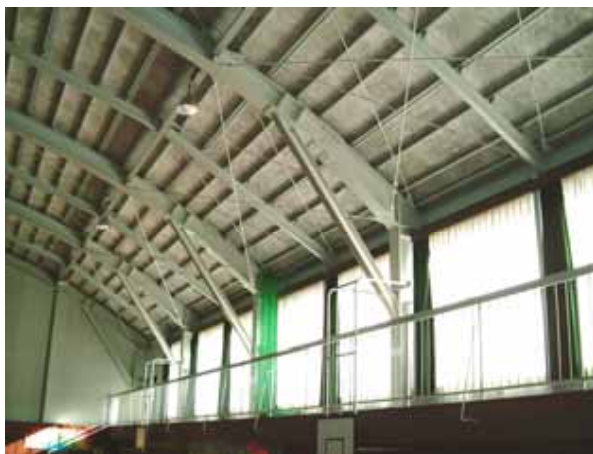
小学校体育館の耐震化を実施
