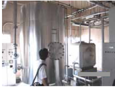
屋上の太陽熱集熱パネル。建物の1階に蓄熱タンク(2,000L)・貯湯槽(4,000L)を配置。
