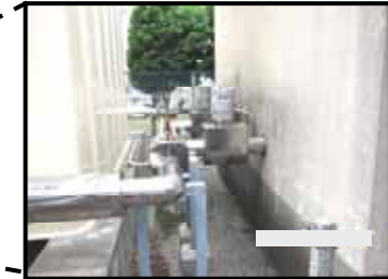
緊急遮断弁を設置した受水槽。災害時に弁が閉まり、配水管断裂による建物内の漏水を防ぐ。
