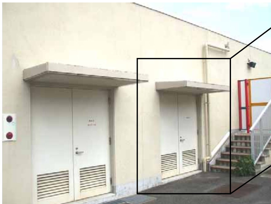
備蓄倉庫(右側)を配置した設備棟
