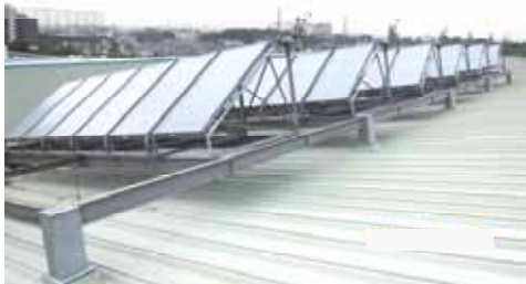
屋上の太陽熱集熱パネル。建物の1階に蓄熱タンク(2,000L)・貯湯槽(4,000L)を配置。
