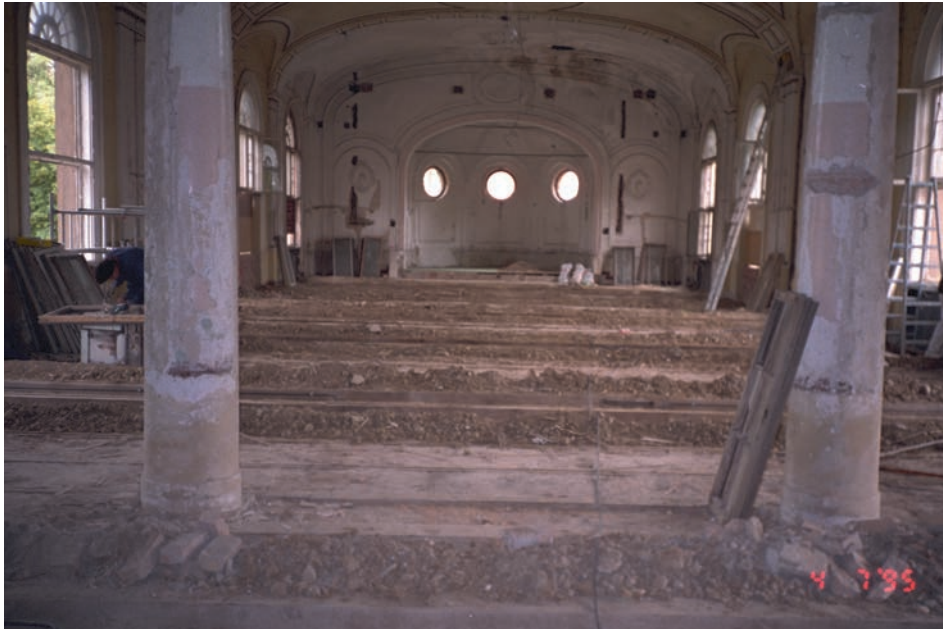
Bauarbeiten in der Aula.
