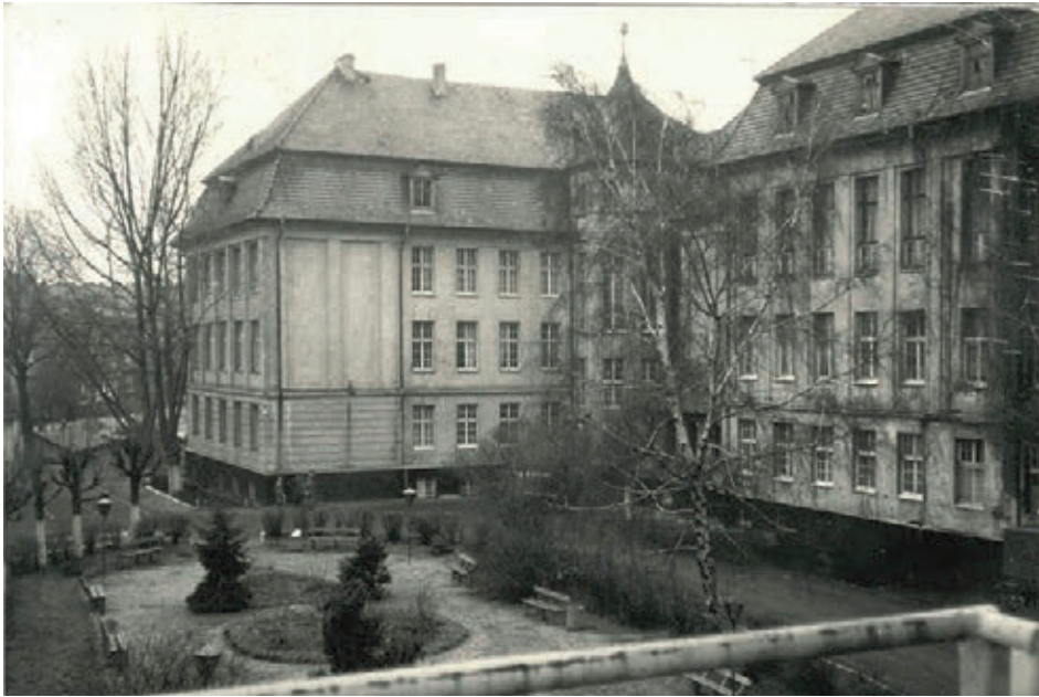
1993/94: Blick in den Innenhof des noch unsanierten Gebäudes
