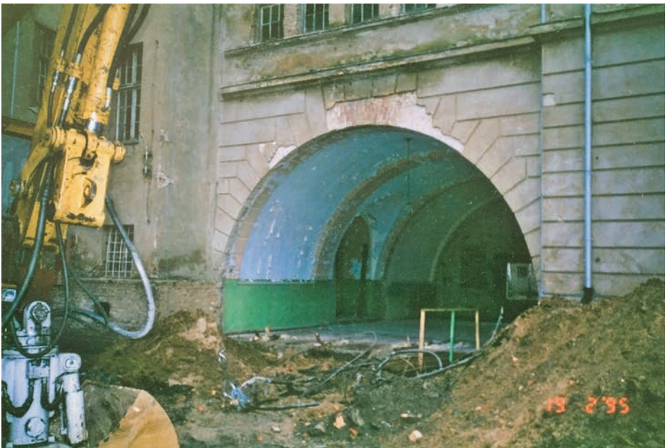
Die Bauarbeiten beginnen. Die heutige Pausenhalle vom Hof aus gesehen.
