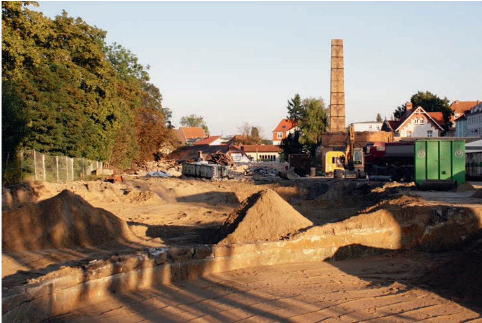
Die Sanierung des Bodens ist fast abgeschlossen.
