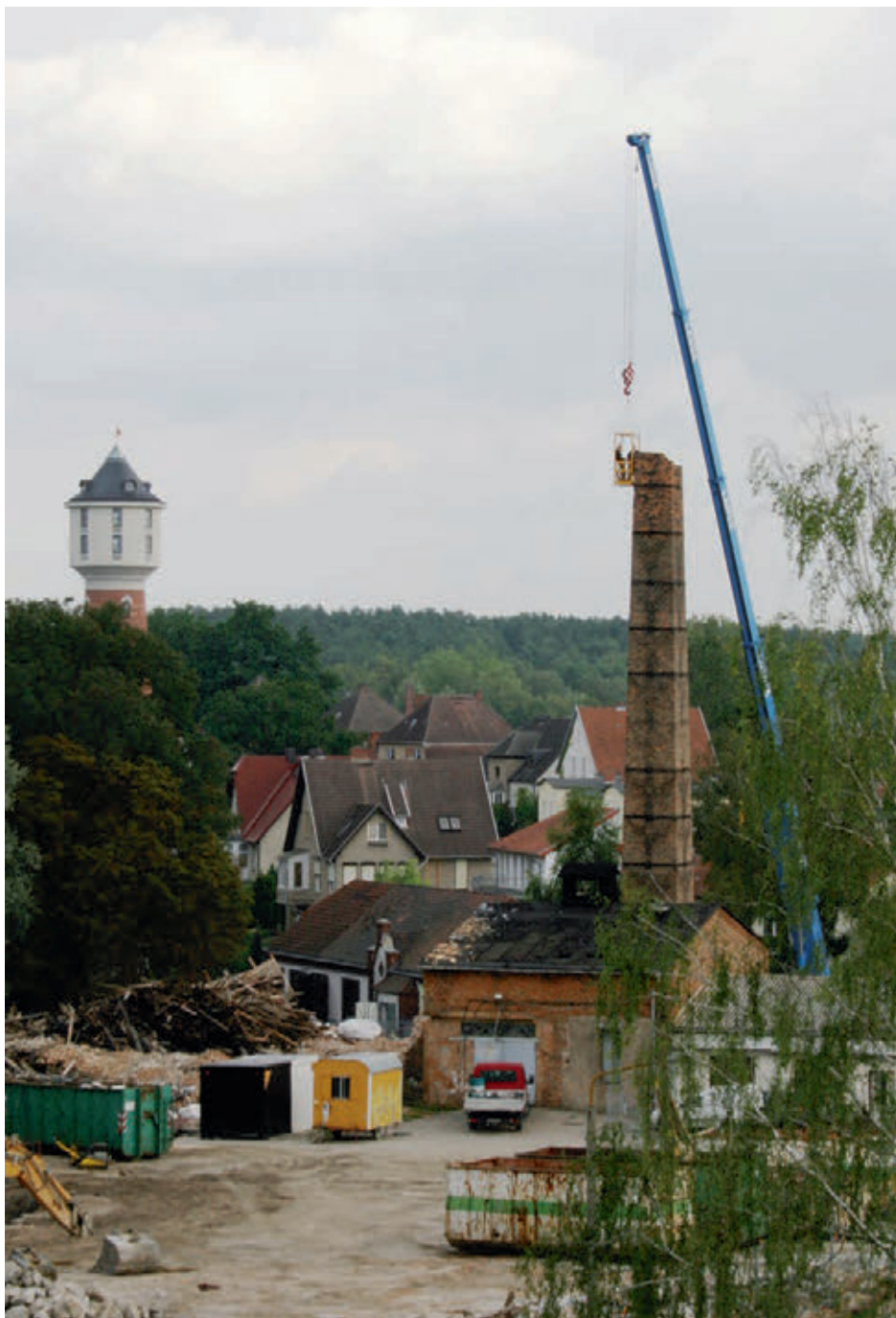
September 2006: Ein Spezialkran hebt eine Gondel mit den Arbeitern in luftige Höhe. Der Schornstein muss Stein für Stein abgetragen werden.
