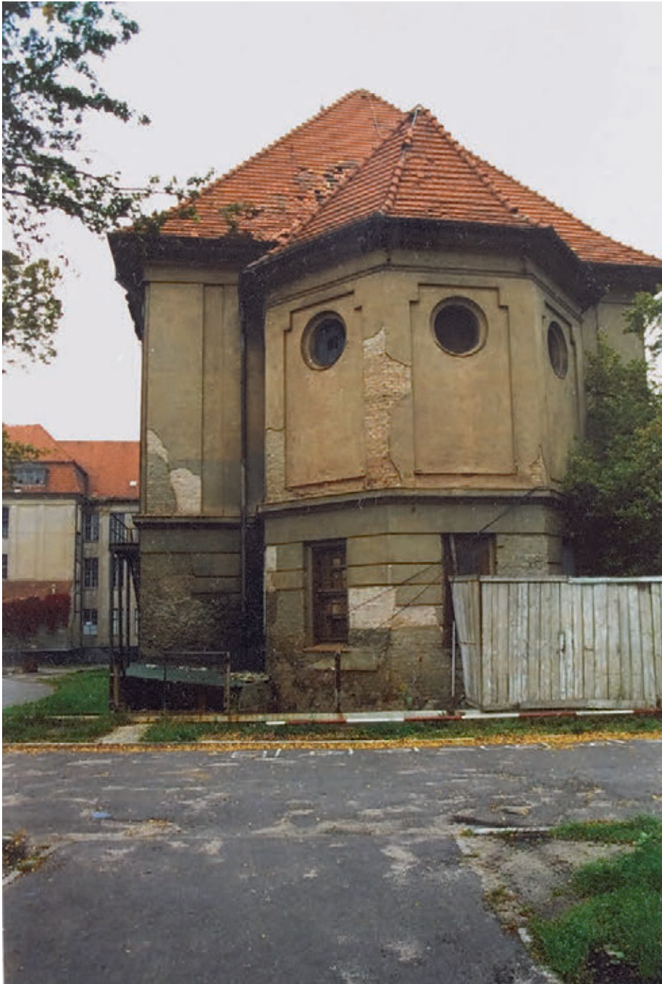
1993/94: Blick von der Carlstraße auf den Aulaflügel
