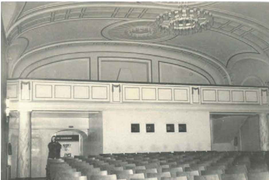
1993/94: Blick auf die Empore in der Aula, die als Kinosaal genutzt wurde. Der originale und heutige Durchgang ist noch zugemauert.
