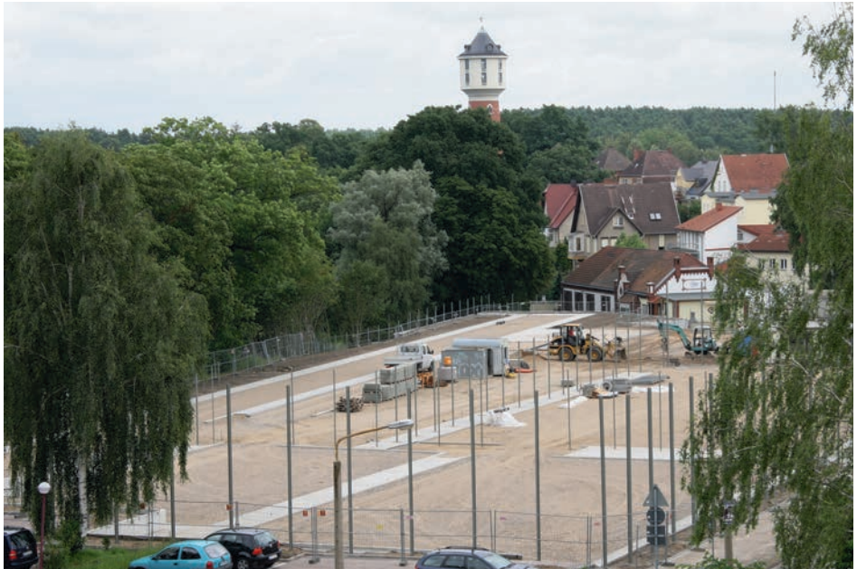
Juli 2007: Vor dem Aufbringen der Asphalttschicht müssen die Pflasterarbeiten abgeschlossen werden.
