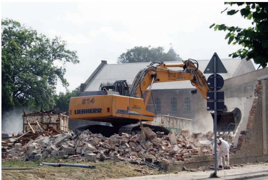
August 2006: Die Bagger rücken an. Mit dem Abriss der Mauer zur Straße beginnen die Bauarbeiten für den neuen Sportplatz.
