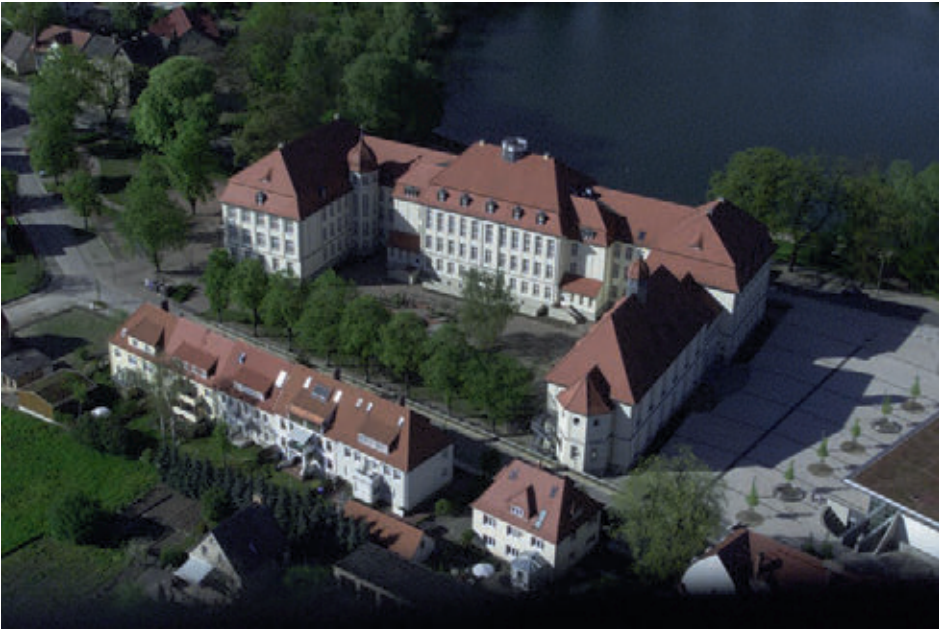
1997: Blick von oben auf das sanierte Gebäudeensemble des Gymnasium Carolinum
