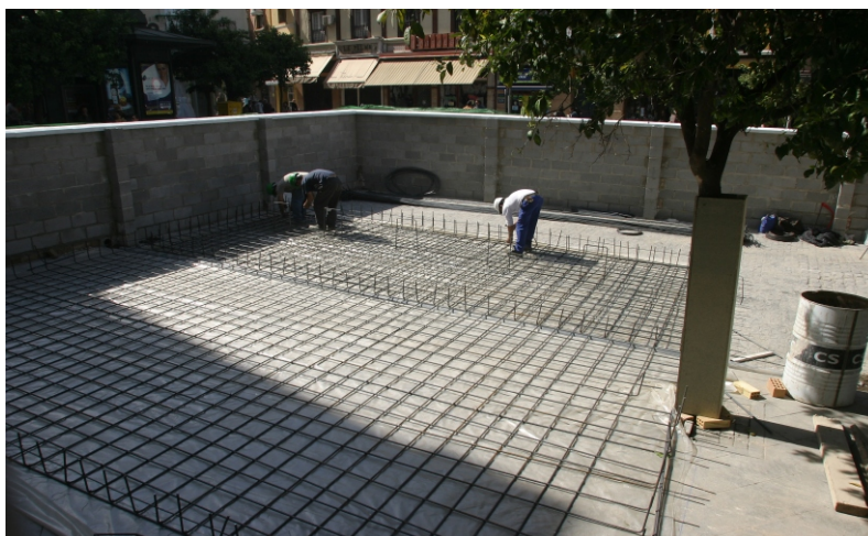
Zona de montaje de armaduras
