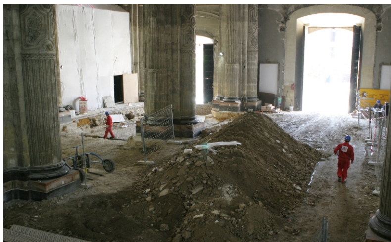
Levantamiento de solería
