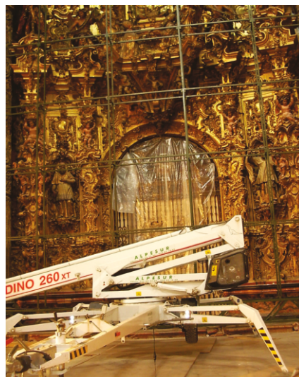
Grúa de apoyo frente al retablo de Pasión
