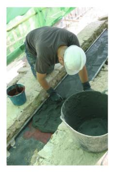
Se termina con el sellado exterior de la roza y relleno de la misma con resina epoxi.
