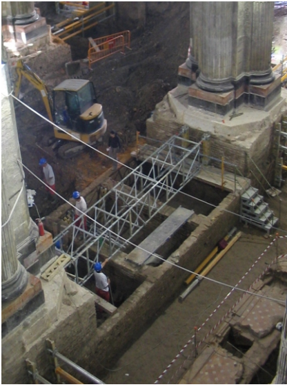
Arriostramiento con torres de carga PERI St100
