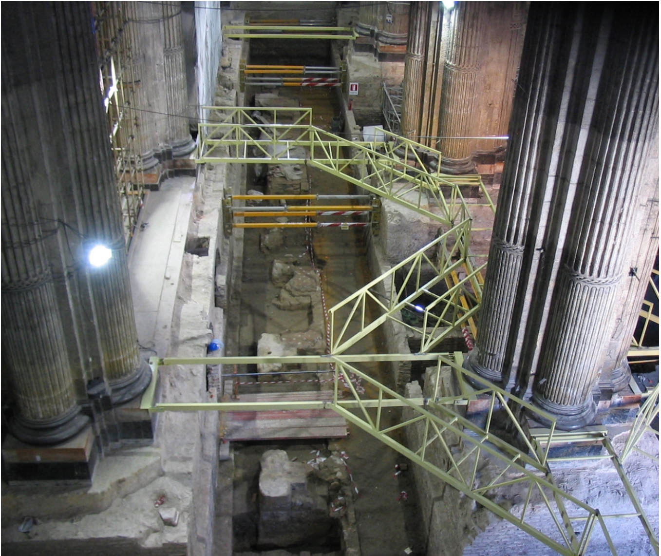
Proceso instalación de pasarelas
