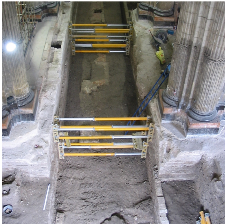
Arriostramientos transversales
