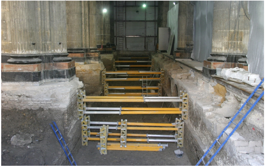
Arriostramiento puntales MULTIPROP y vidas de celosía GT24
