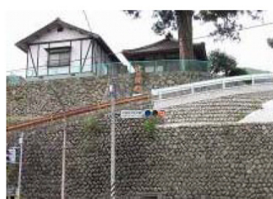
太田川中上流部で見られる玉石を用いた石垣
