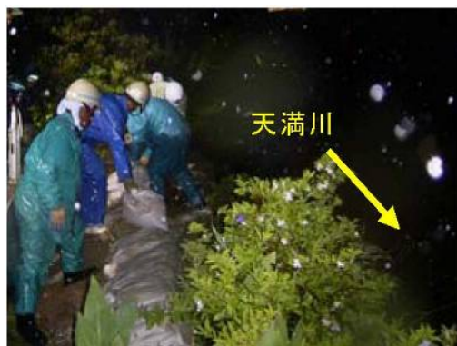
観音地区土のう積み状況 H17.9洪水の状況
