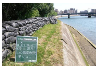
(土のうの設置)
