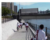
北大橋左岸のアンダーパス
