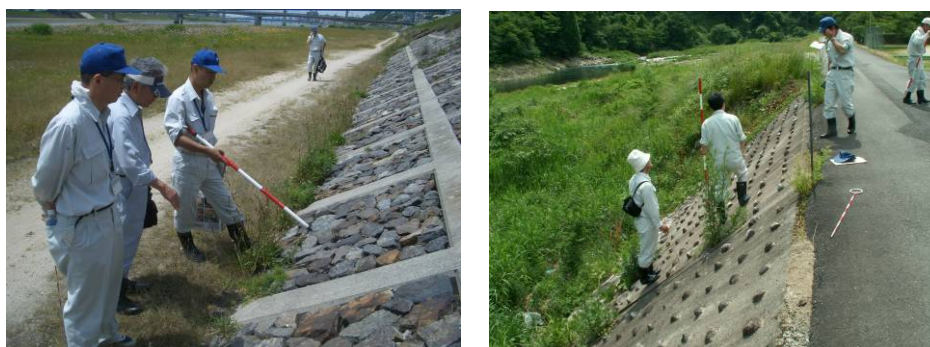
図 6-4-1 職員と防災エキスパートによる合同堤防点検
