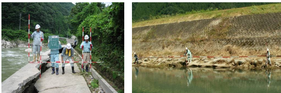
図 6-4-3 出水後の点検
