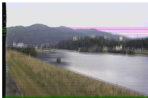
カメラ装置劣化による画像の乱れ
