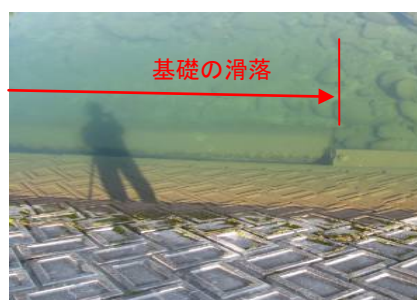
図 5-3-1 河床の洗掘により損傷した事例（対策済）
