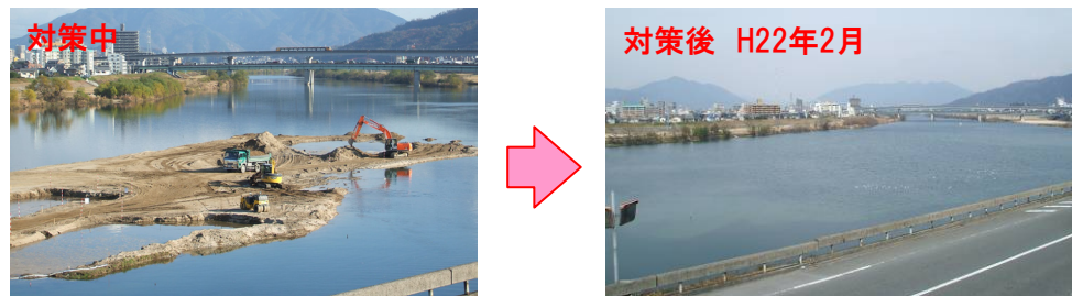
図 5-2-2 分派地点の堆積土砂掘削
