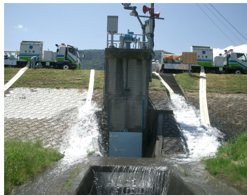
排水ポンプ車操作訓練
