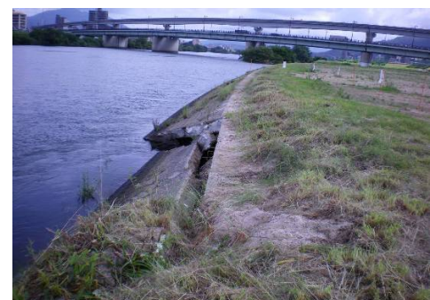
図 3-1-3 局所的洗掘による損傷例 (対策済)
