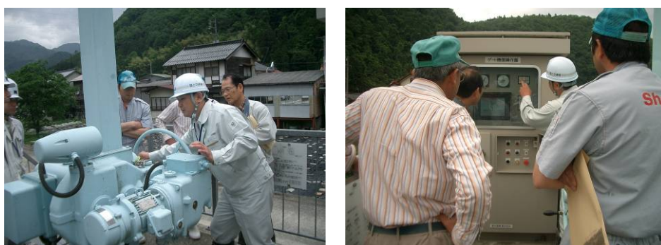
図 6-4-7 職員と操作員による機械設備を伴う河川管理施設の合同点検
