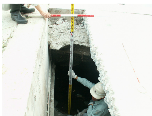
(護岸基礎下部より背面土砂が吸い出され、空洞化が発生：太田川 69K500 付近)
