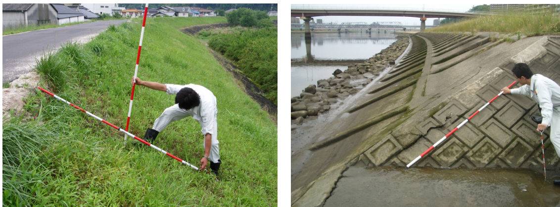
図 5-3-3 堤防点検の状況
