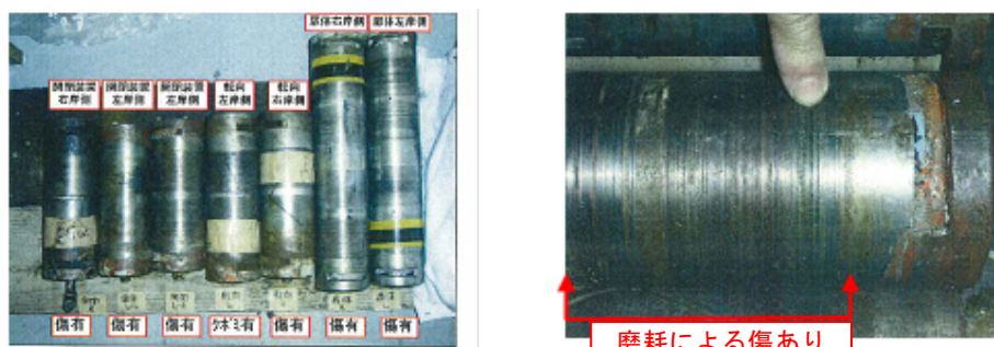
図 5-3-8 大芝水門の長寿命化対策例（3号ゲートの巻き上げ機更新）
