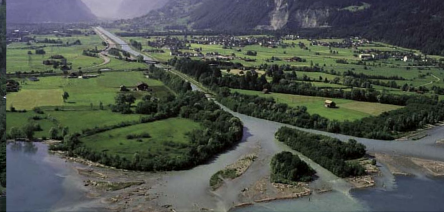
Wiederherstellung des Reussdeltas, Kanton Uri ||
