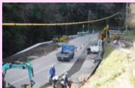
1工区改良工事
