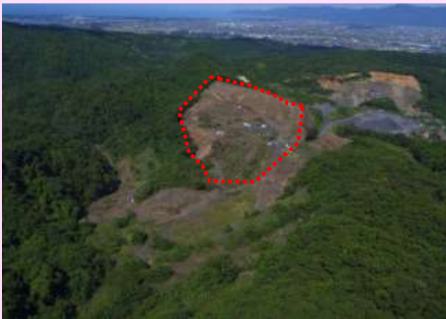
↑赤の点線内が施設敷地
