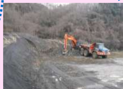
6工区改良工事
