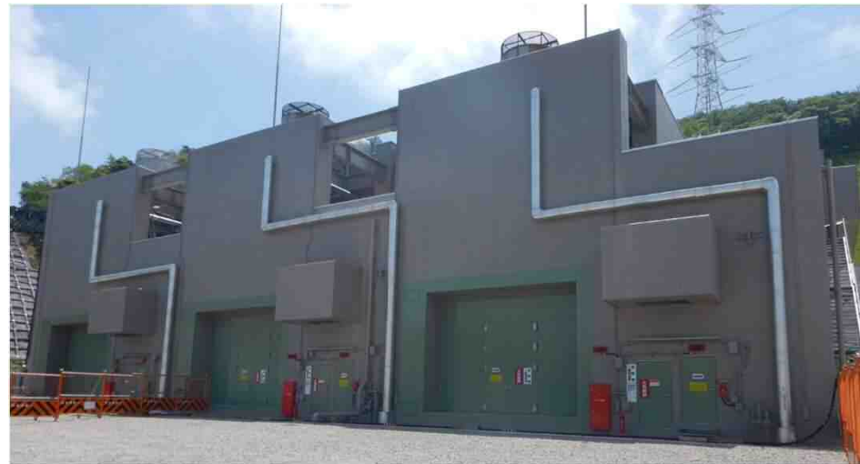
建物工事状況(平成30年5月14日撮影)
