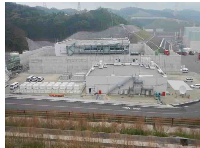
工事状況(平成30年4月23日撮影)
