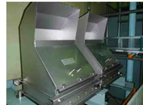
■ : 静的触媒式水素処理装置
