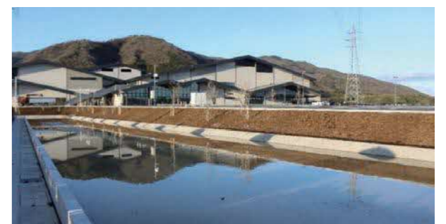
㉗洪水調整池 敷地内の雨水を適切に貯留し流出増を抑えます
