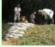
漏水箇所の補修
