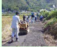
未舗装農道の舗装
