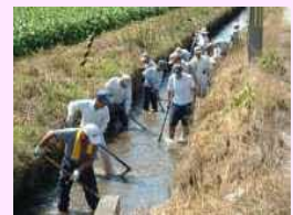
水路の泥上げ
