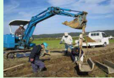
コンクリート水路の更新
