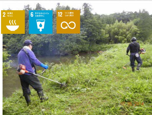
ため池堤体の草刈り
