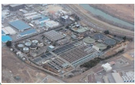
6 伏見水環境保全センター
