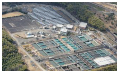
③ 新山科浄水場
