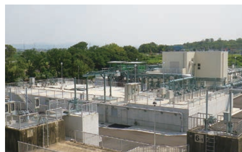
大雨時に流入する大量の下水を連続してろ過することで、河川への放流水質を向上させる施設です。
