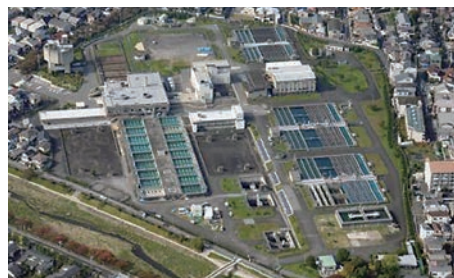
② 松ヶ崎浄水場
