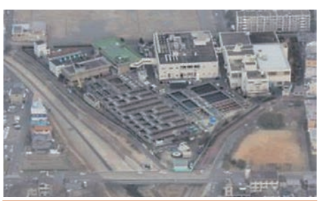
5 鳥羽水環境保全センター 吉祥院支所
