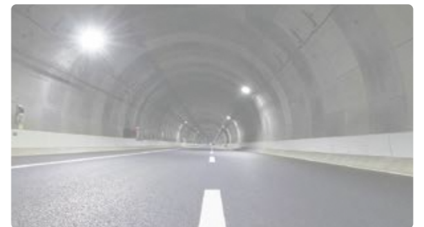
③ 横浜北西トンネル
