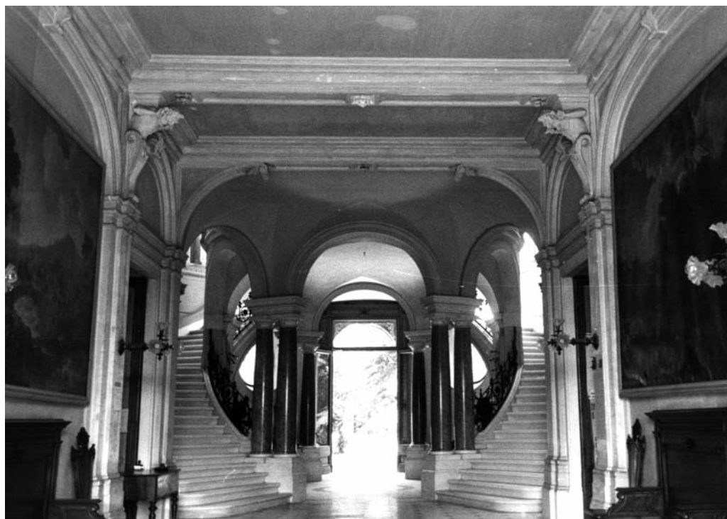
2. Genova, Villa Raggio. La scala elicoidale a doppia rampa; foto storica anni Trenta del Novecento. (Archivio Storico del Conservatorio di Musica "N. Paganini")
