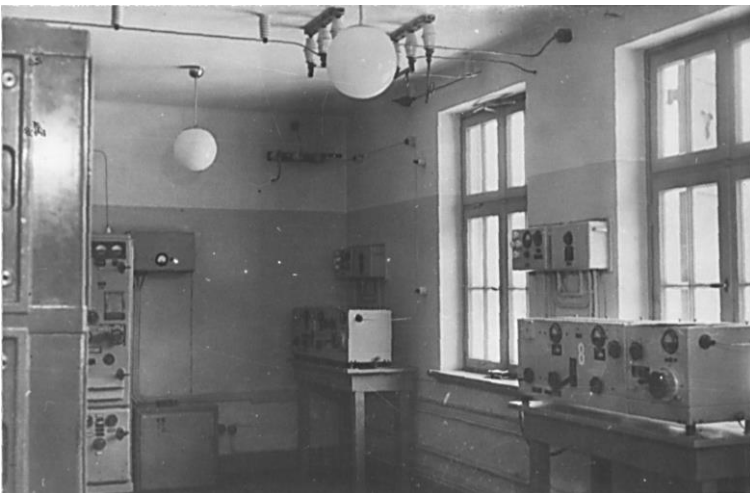
Abb. 20: Senderraum in "Vorwerk", auf den beiden Tischen rechts steht jeweils ein Lorenz-Sender und hinten links, etwas verdeckt, ein Telefunken-Sender.
