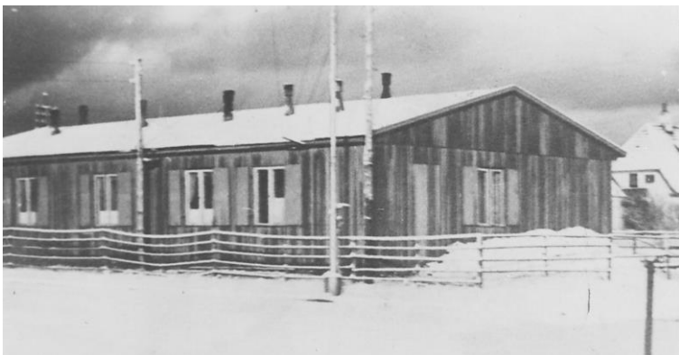
Abb. 24: Funkmeldekopf Skagen/Dänemark der Funkzentrale Hamburg-Wohldorf
