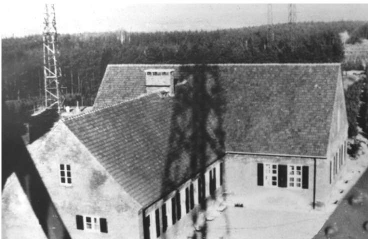
Abb. 6: Betriebs- und Empfangsgebäude der Abwehr Zentralfunkstelle Belgig
