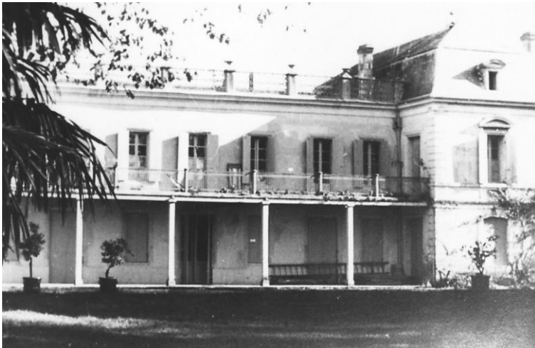
Abb. 23: Funkmeldekopf und Relaisfunkstelle Libourne/Dordogne der Funkzentrale Hamburg-Wohldorf
