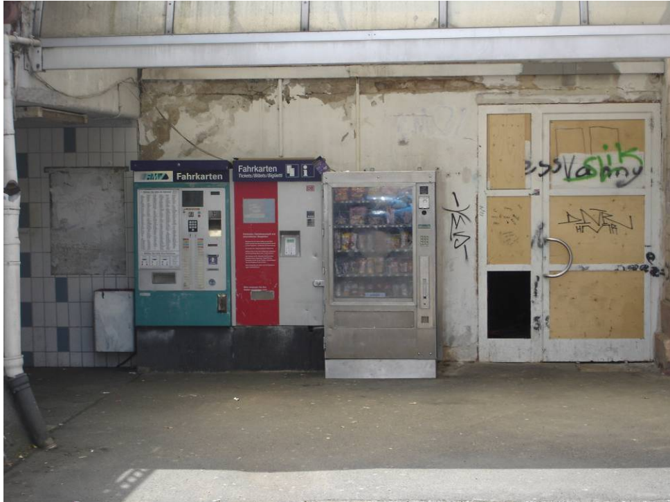
Abbildung 28: Unterführung im Bahnhof Babenhausen
