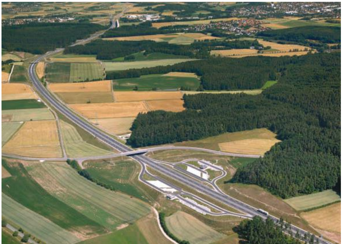
Mittelabschnitt der A73 mit der PWC-Anlage Coburger Forst.
