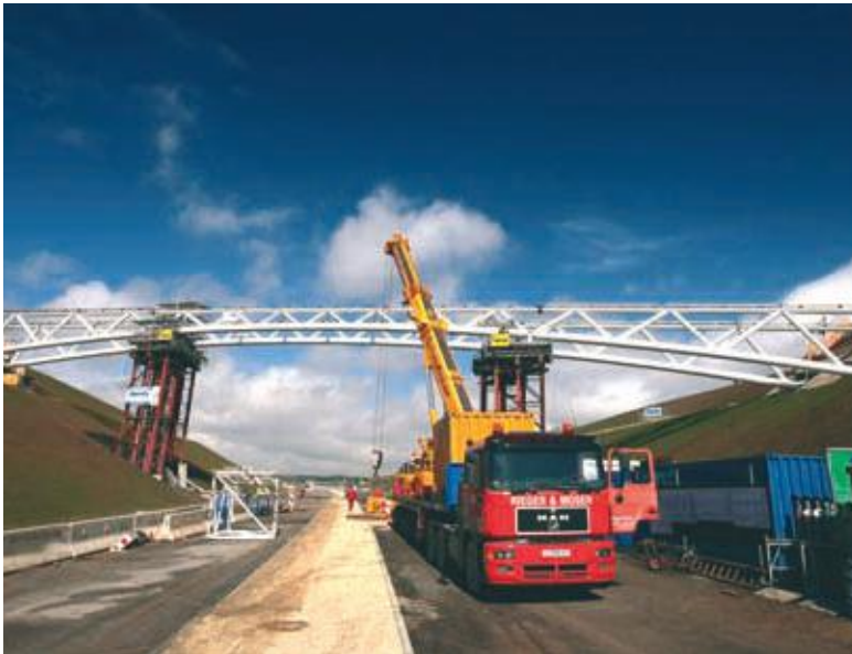
Montage des Rohrfachwerks.
