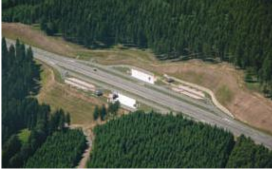
PWC-Anlage Adlersberg Auf Grund der dichten Aufeinanderfolge von Talbrücken ist der gewählte Standort der einzig mögliche für eine unbewirtschaftete Rastanlage. Der Rastplatz verfügt je Richtung über 8 Lkw- und 20 Pkw-Stellplätze.
