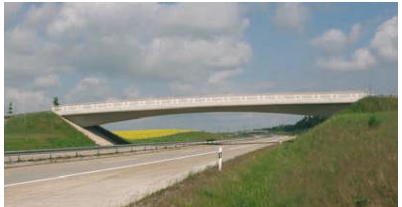
Einfeldbrücke im Nordabschnitt.
