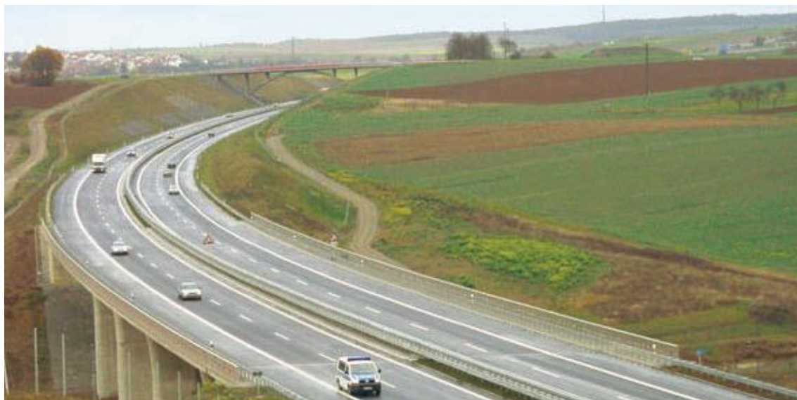
Störungsfreier Verkehrsfluss auf der neuen Autobahn, hier in Bayern südlich Pfersdorf.
