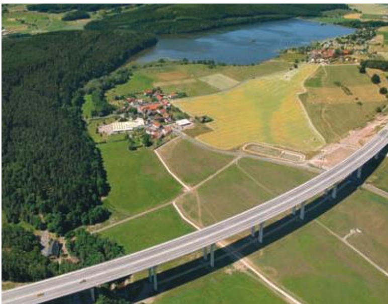
Die Talsperre Ratscher mit der Talbrücke Schleuse im Vordergrund.
