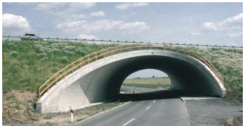
Beispiel für eine Autobahnbrücke.
