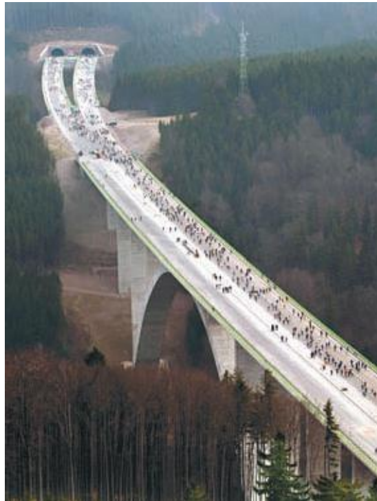
Ein einmaliges Erlebnis für Tausende von Läufern: Der Rennsteiglauf am 30. März 2003 durch alle Tunnel der Kammquerung. Hier der Blick auf die Talbrücke Wilde Gera bzw. Schwarzbachtal und auf das Portal des Tunnels Alte Burg.
