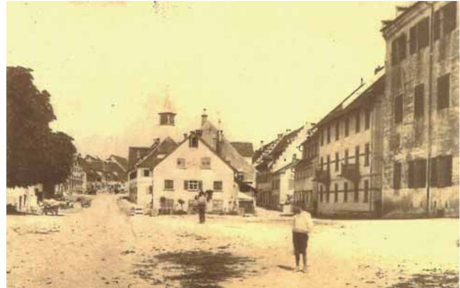
Montfortstraße und Schulstraße vom Montfortplatz aus (historisches Foto)
