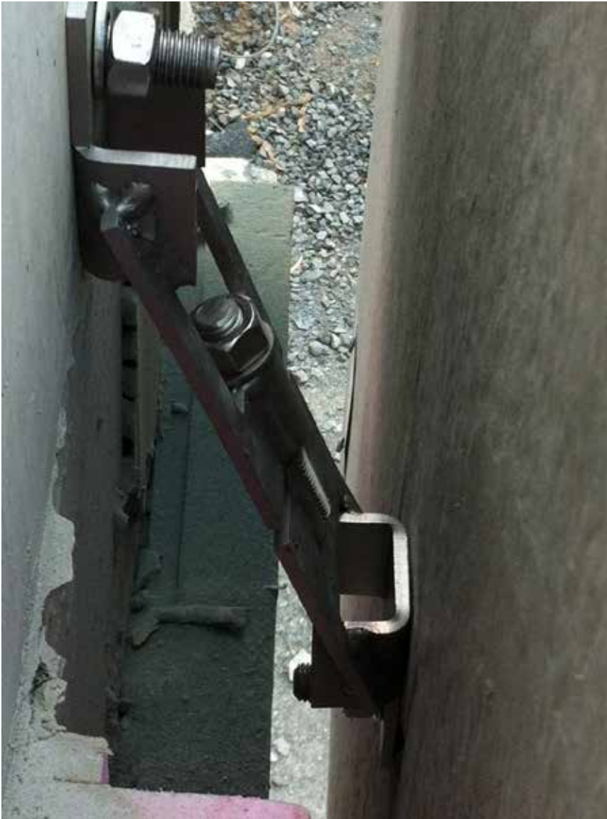
Bild 2: Hängezuganker aus nichtrostendem Stahl sorgen für die Sicherheit von vorgehängten Fassaden (Foto: Wilhelm Modersohn GmbH & Co. KG, Spenge)
