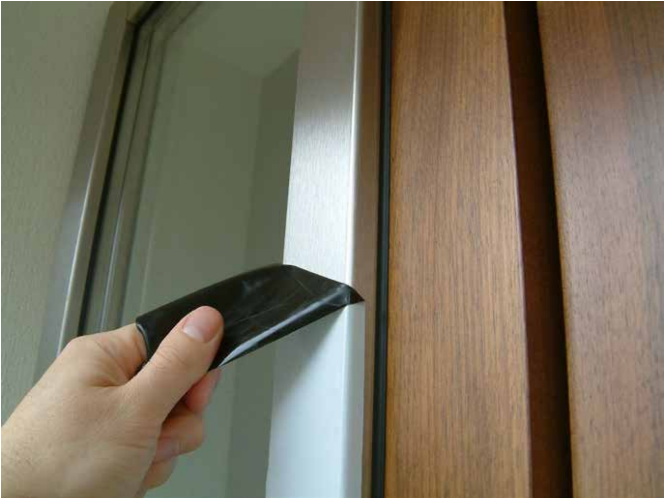
Bild 6: Die Technik des partiellen Folierens der späteren Sichtflächen von Bauprofilen aus Edelstahl Rostfrei erleichtert das Entfernen der Schutzfolie nach dem Einbau erheblich (Foto: VOGEL-BAUER Edelstahl GmbH & Co. KG, Solingen)
