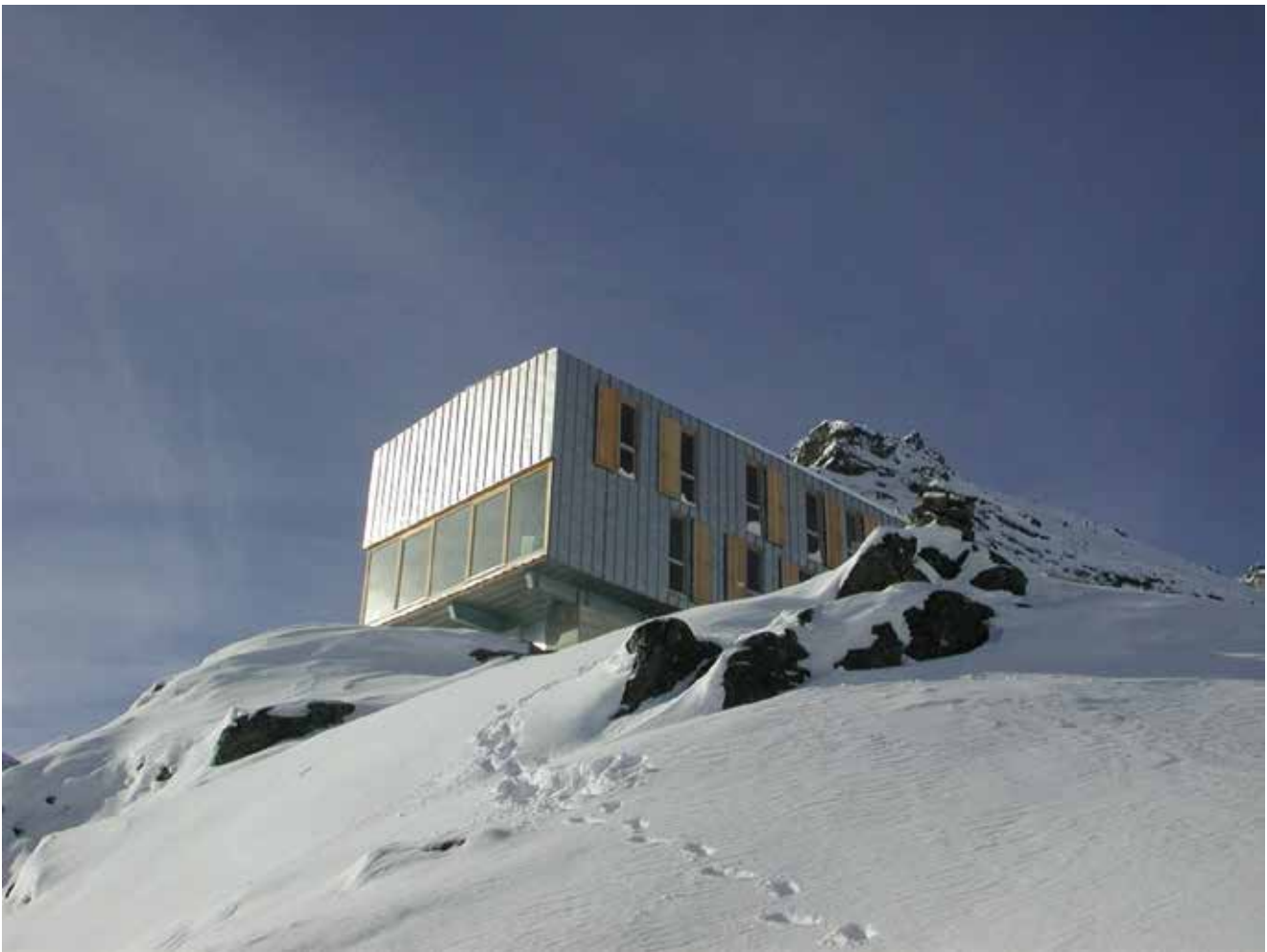
Bild 5: Die beidseitig mustergewalzte Oberflächenausführung der nichtrostenden Fassadenbekleidung der von Meier Associés Architectes S.A. realisierten Schutzhütte Topali des Alpenvereins Matternal, St. Niklaus, schimmert reflexionsarm im Sonnenlicht (Foto: Aperam Stainless Services & Solutions Germany GmbH, Erkrath)
