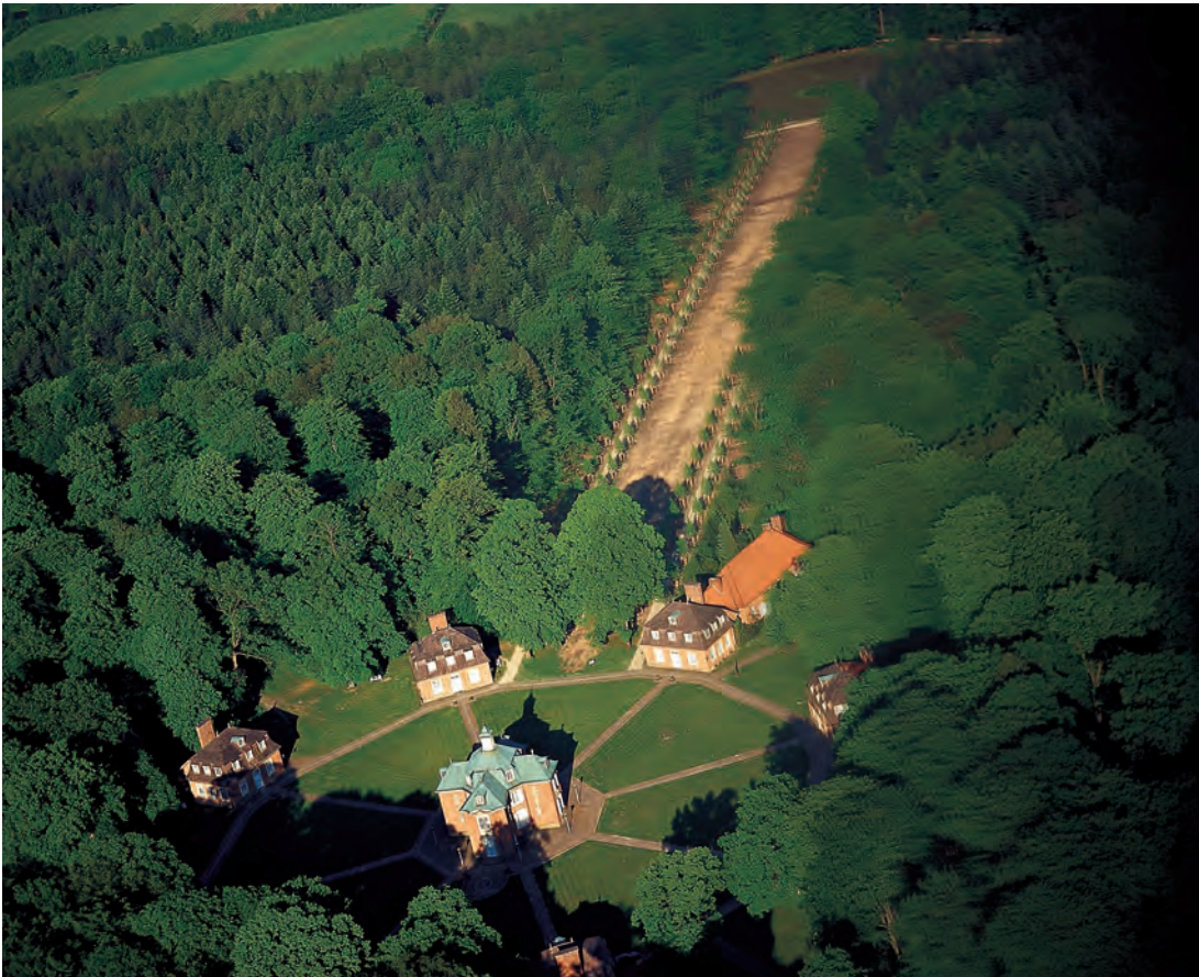
Abb. 467 Die Sanierung der Alleen im Schlosspark von Clemenswerth: eine von zahlreichen Maßnahmen, um ein Denkmal von europäischem Rang zu erhalten oder auch den ursprünglichen Plänen wieder anzunähern.
