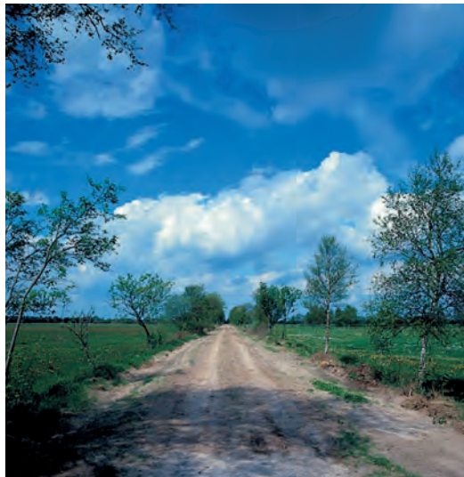
Abb. 271 Unbefestigte Gemeindewege wie hier im Moor bei Esterwegen waren üblich.
