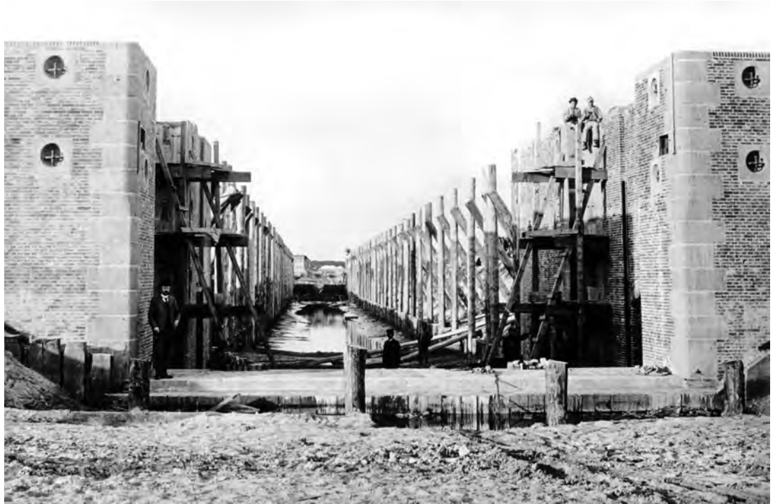
Abb. 275 Die Schleuse Düthe, nördlich von Lathen, des Dortmund-Ems- Kanals kurz vor der Fertigstellung (Foto 1897)
