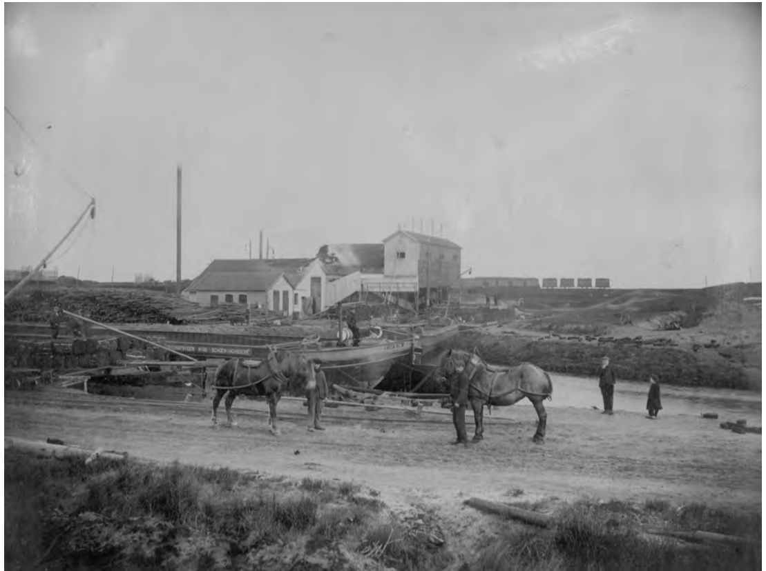
Abb. 277 Eine Torfstreu­fabrik in Schöninghsdorf (Foto um 1905). Die Treidelpferde im Vordergrund wurden für die Torfschiffe auf dem Süd-Nord-Kanal benötigt.
