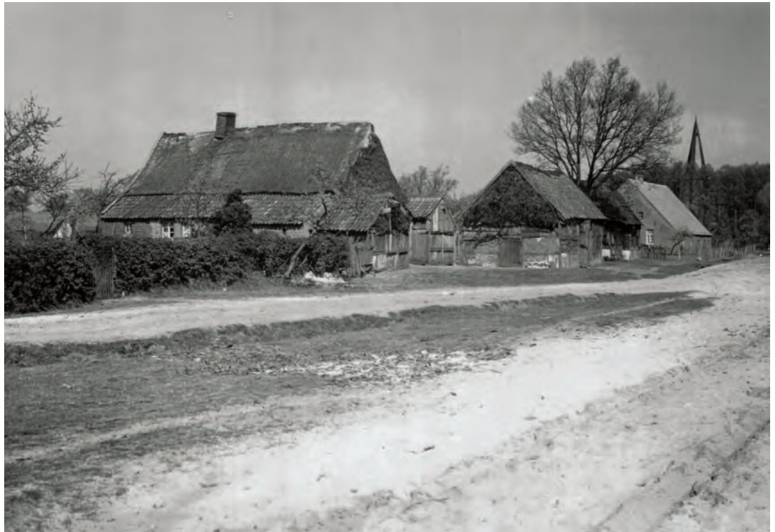
Abb. 287 Holz, Fachwerk, Lehm und Stroh waren die traditio- nellen Baustoffe für das emsländische Bauernhaus – hier in Groß Hesepe um 1930.
