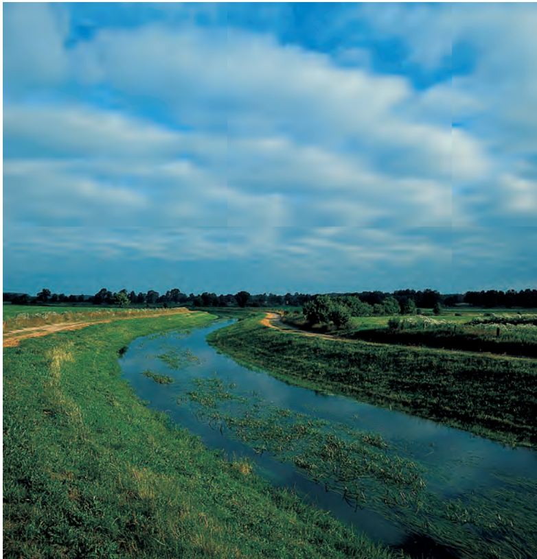
Abb. 315 Die Verbesserung der Wasserwirtschaft war ein großes Anliegen bei der Emslanderschließung, dazu gehörte auch die Begradigung und Eindeichung von Gewässern – hier die Nordradde bei Sögel.
