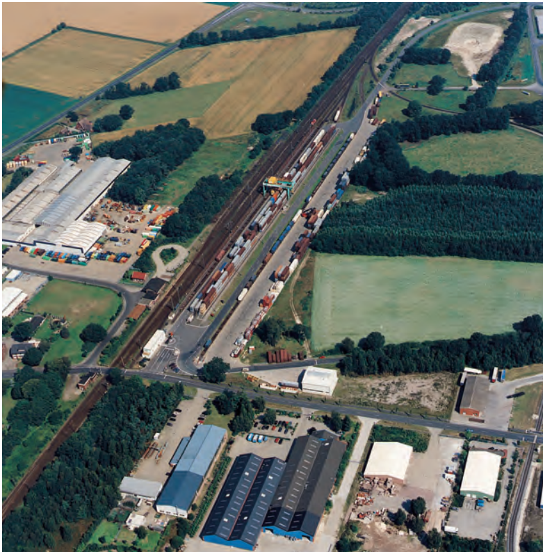
Abb. 400 Das Herzstück des Güterverkehrszentrums (GVZ) in Dörpen: Die Umschlaganlage für den Kombinierten Verkehr
