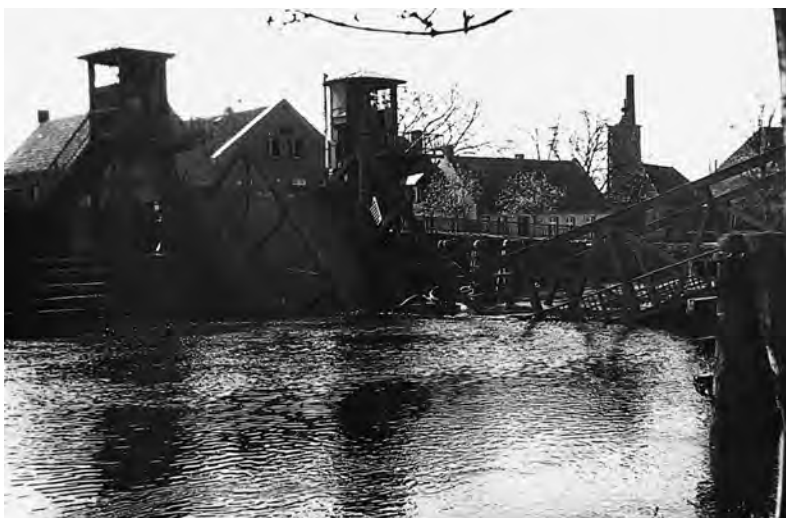
Abb. 267 Die zerstörte Hubbrücke über den Dortmund-Ems-Kanal in Meppen Anfang April 1945
