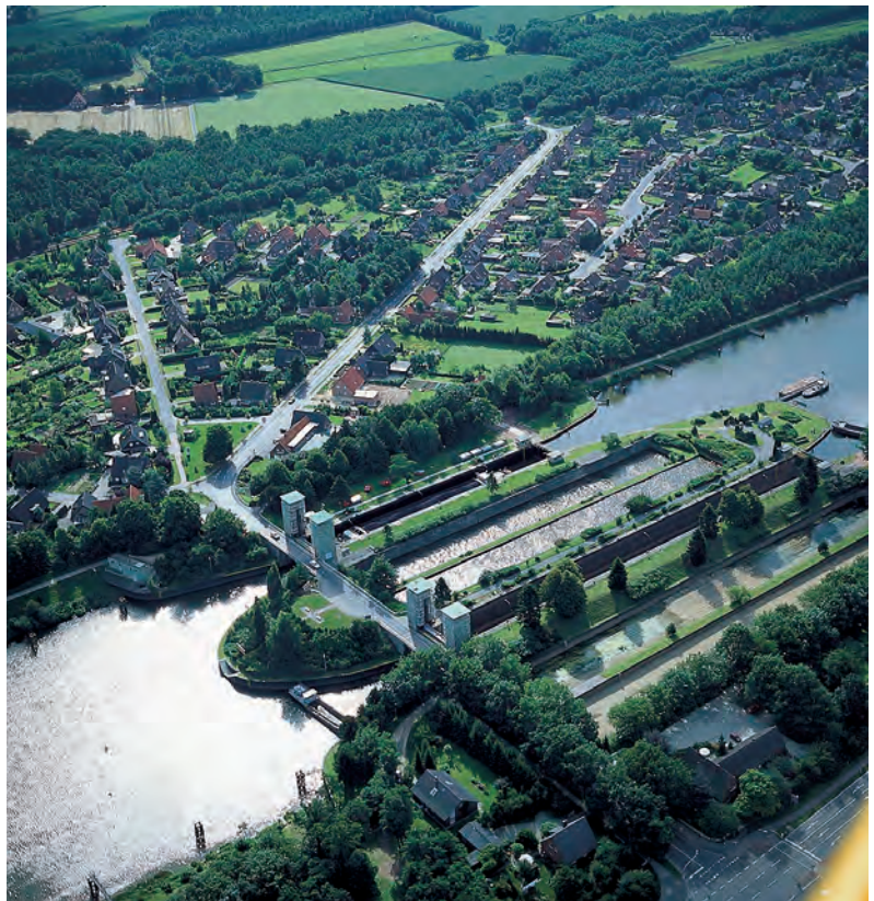
Abb. 396 Schleuse Meppen-Teglingen des Dortmund-Ems-Kanals
