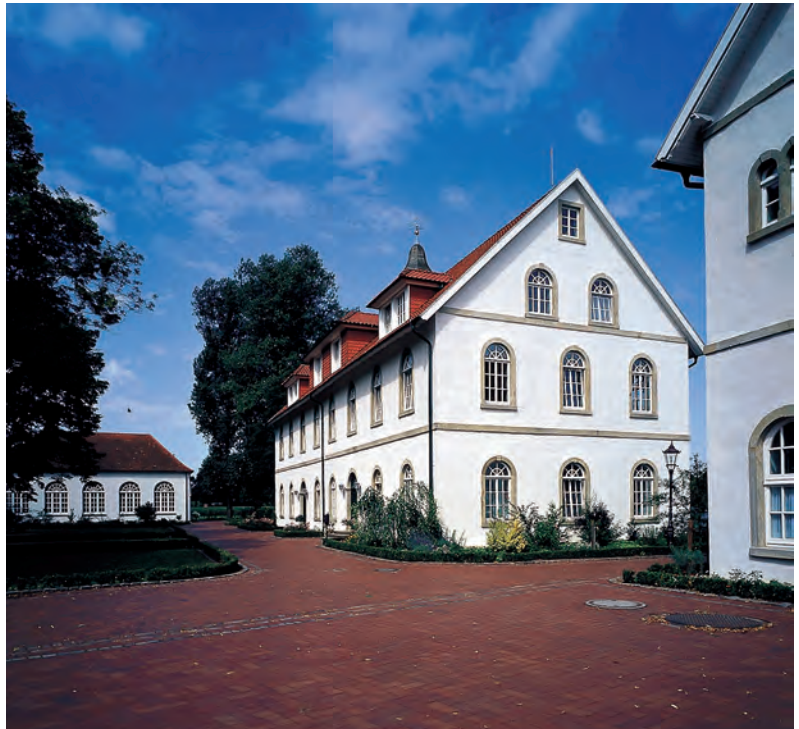
Abb. 452 Das Gebäude der ehemaligen Hübert'schen Handelsschule in Schapen wurde zu einer Langzeitbetreuungseinrichtung für Schwerstmehrfachbehinderte umgebaut.
