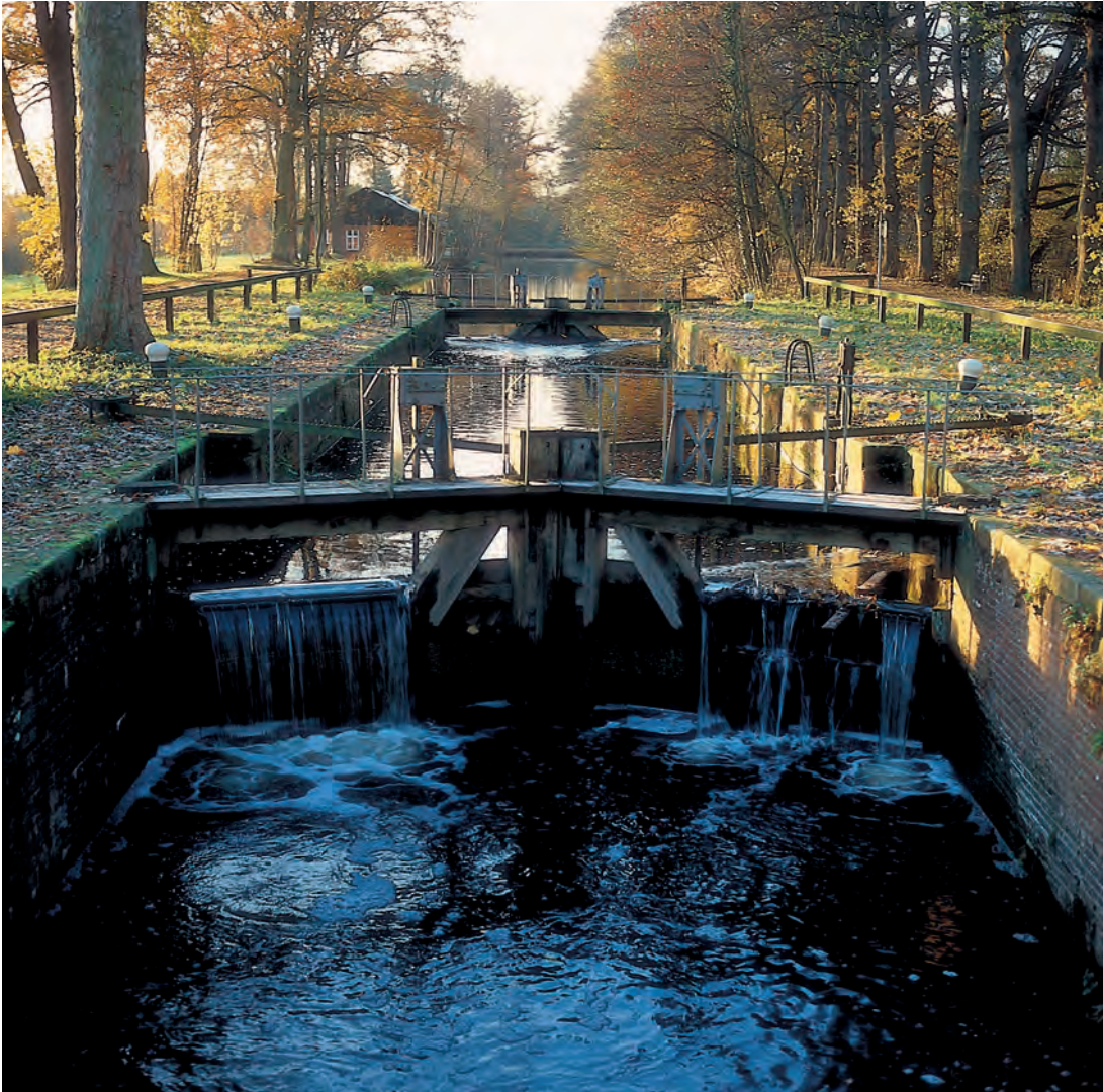
Abb. 269 Koppelschleuse am Hanekenkanal in Meppen
