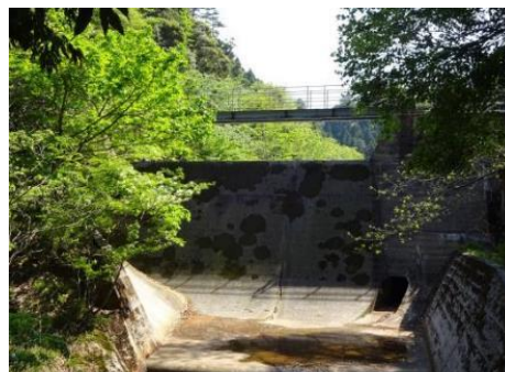
南谷取水ダム
