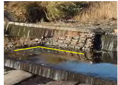
木柁土嚢魚道の設置場所（黄線）
