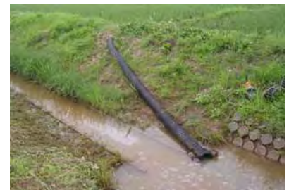
波付き丸形の設置状況
