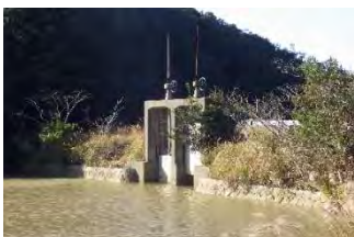
石淵地区の水門（陸側）
