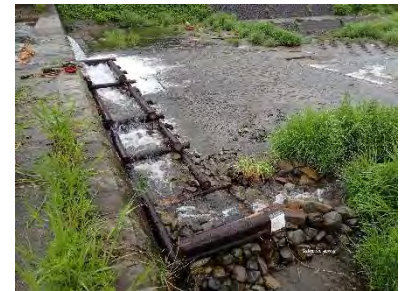
木柁土嚢魚道
