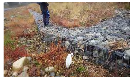
カゴマット (拡大) (上流側から撮影)
