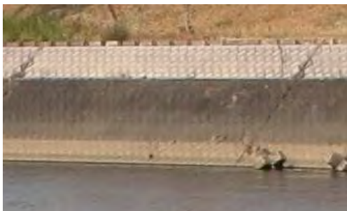
施工前の状況 （写真提供：川内川河川事務所）
