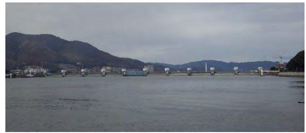
海側から見た芦田川河口堰 全長450m、水門10基
