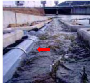
デニール式魚道内に設置されたシラスウナギ専用魚道 (赤矢印のグレーの塩ビパイプ)
