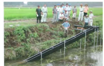
可動式魚道の設置状況
