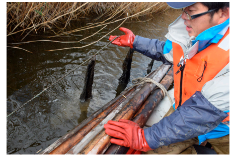
水質浄化装置の敷設
