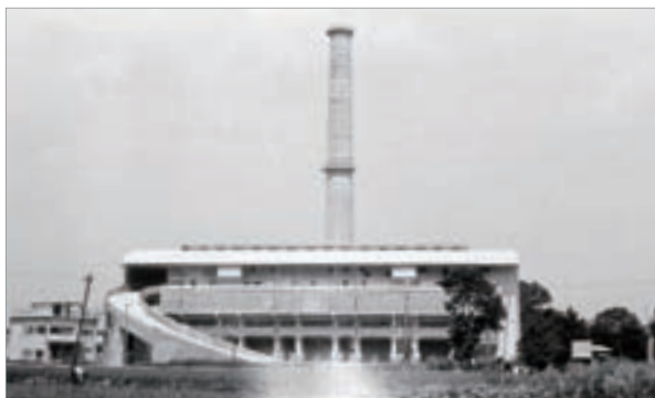
1958年、東京都に竣工した第五清掃工場は、大型焼却炉6基を備え、生ごみ等水分の多いごみの焼却前の乾燥、ベルトコンベヤによる焼却灰搬出装置などを備えるほか、地元には余熱利用による温水給湯サービスを提供するなど、新しい考え方をとり入れて設計された工場であった。
