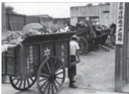
各戸からごみを収集してきた手車。収集したごみは扱ひ場や路上で運搬専用の自動車や船舶に積み替えられて、焼却場や埋立処分場に運搬された。
