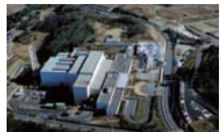
町田市リサイクル文化センター 写真提供：東京都
