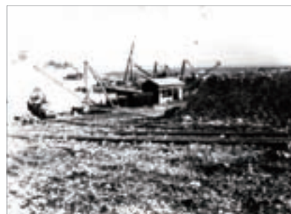
東京湾の夢の島埋立処分場。ごみの焼却処理や覆土がほとんど行われていなかったため、生ごみの発酵等により発生したガスによる自然発火や悪臭、ハエの大量発生が問題となった。
